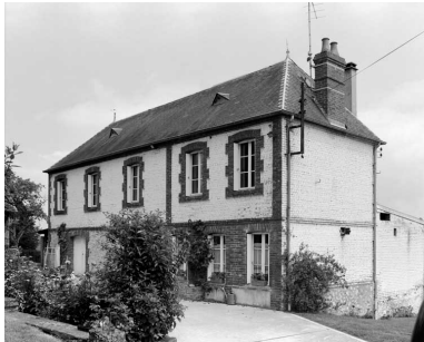
Logement patronal. Vue prise du sud-ouest. Phot. François Decaëns IVR25_19951401526X
