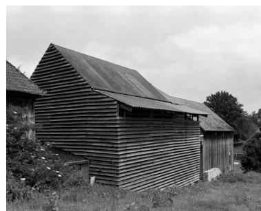
Remise (affectée au séchage de la laiche, ou roseau de mare) et pièce d'affinage. Vue prise du sud-ouest. Phot. François Decaëns IVR25_19951401528X
