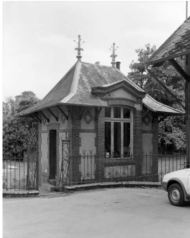
Bureau. Vue prise du nord-ouest. Phot. François Decaëns IVR25_19951401525X
