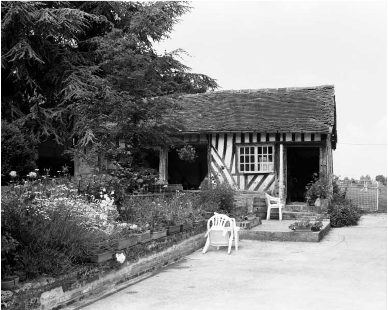
Remise. Vue prise du sud.
