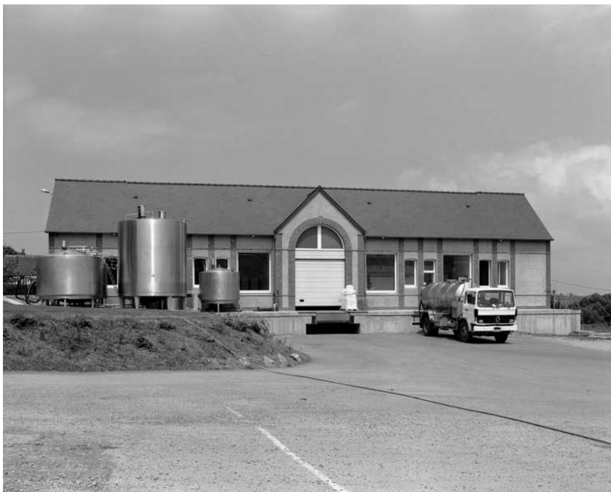
Atelier de fabrication. Vue prise du sud.
