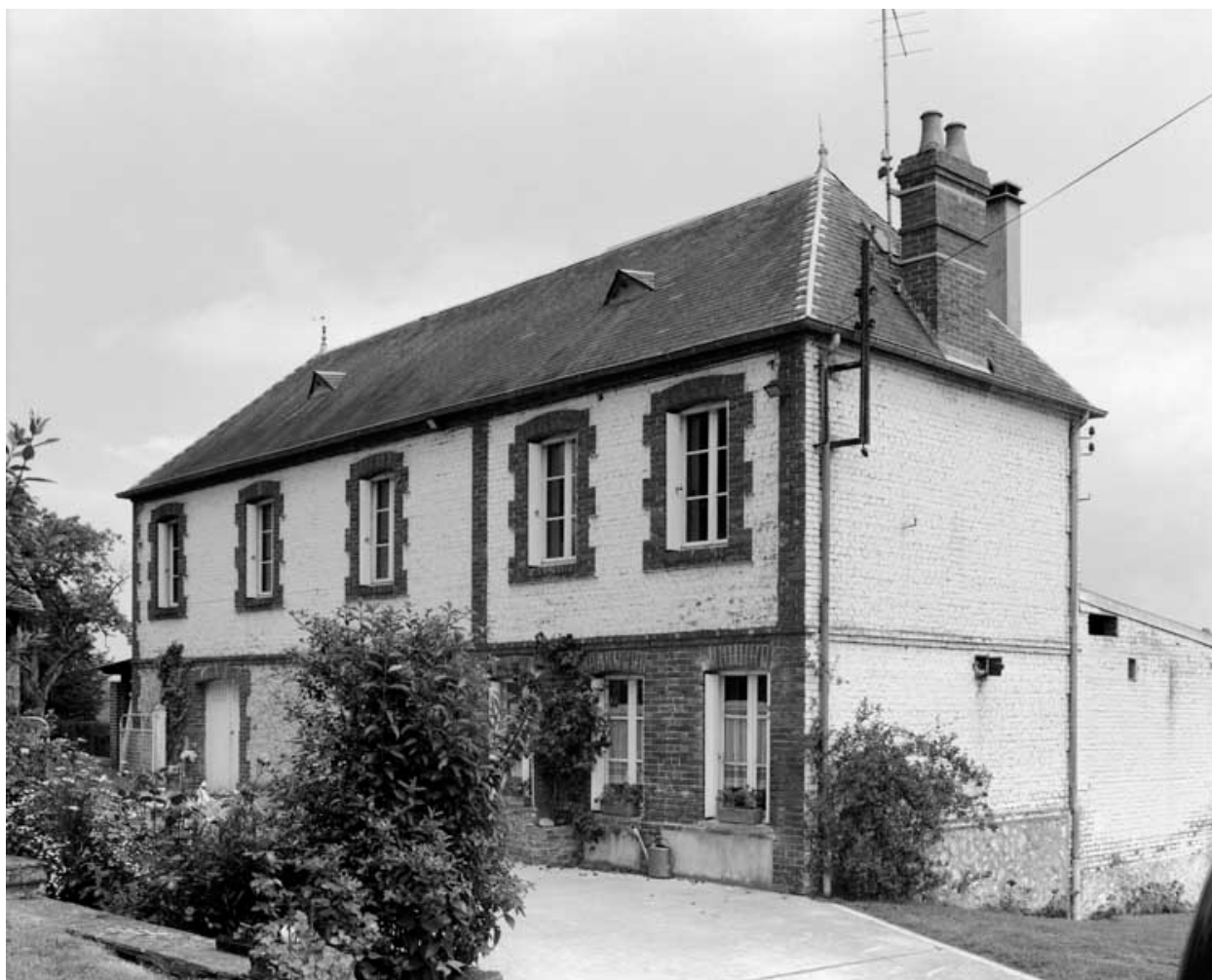
Logement patronal. Vue prise du sud-ouest.
