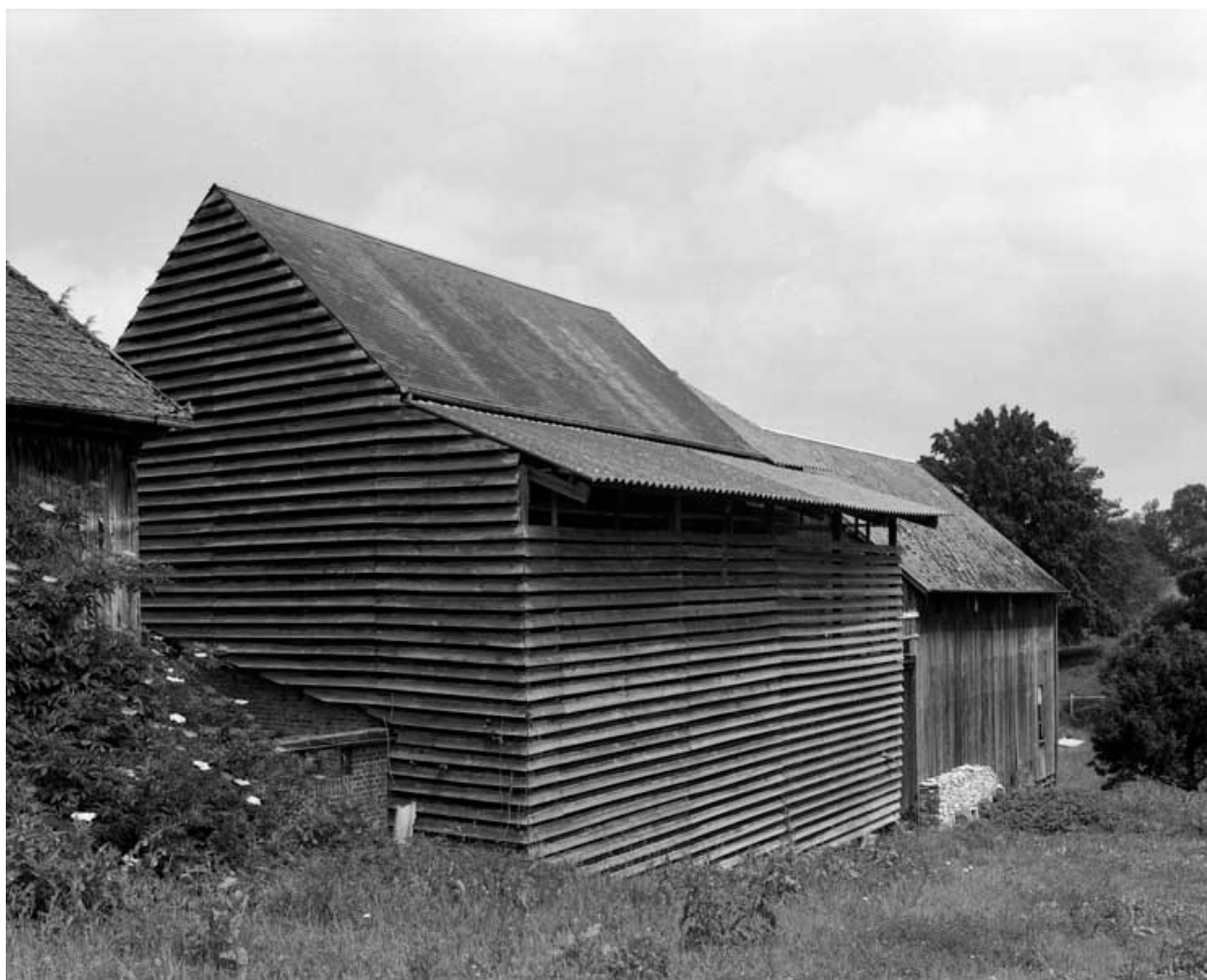
Remise (affectée au séchage de la laiche, ou roseau de mare) et pièce d'affinage. Vue prise du sud-ouest.
