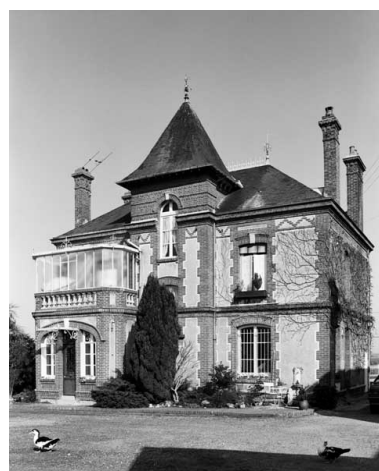
Logement patronal. Vue prise du sud. Phot. Pascal Corbierre IVR25_19951401229X
