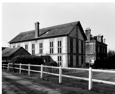
Pièce d'affinage et logement patronal. Vue prise du nord-est. Phot. Pascal Corbierre IVR25_19951401231X
