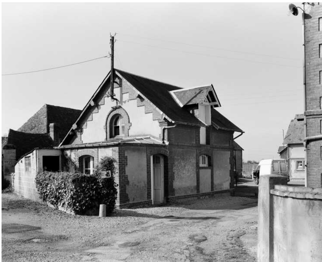
Parties agricoles. Vue prise du nord-est.
