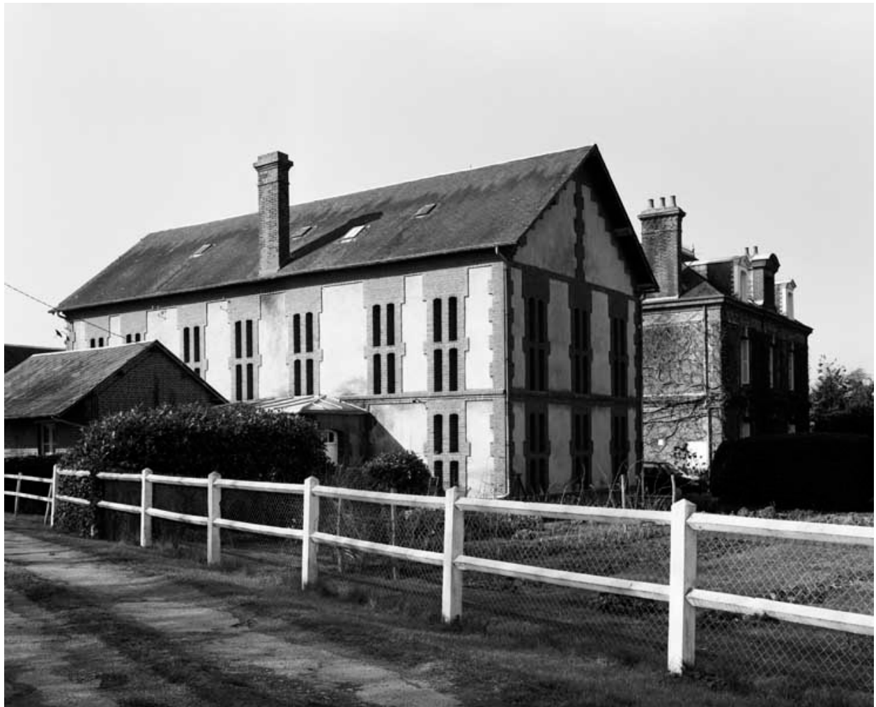
Pièce d'affinage et logement patronal. Vue prise du nord-est.
