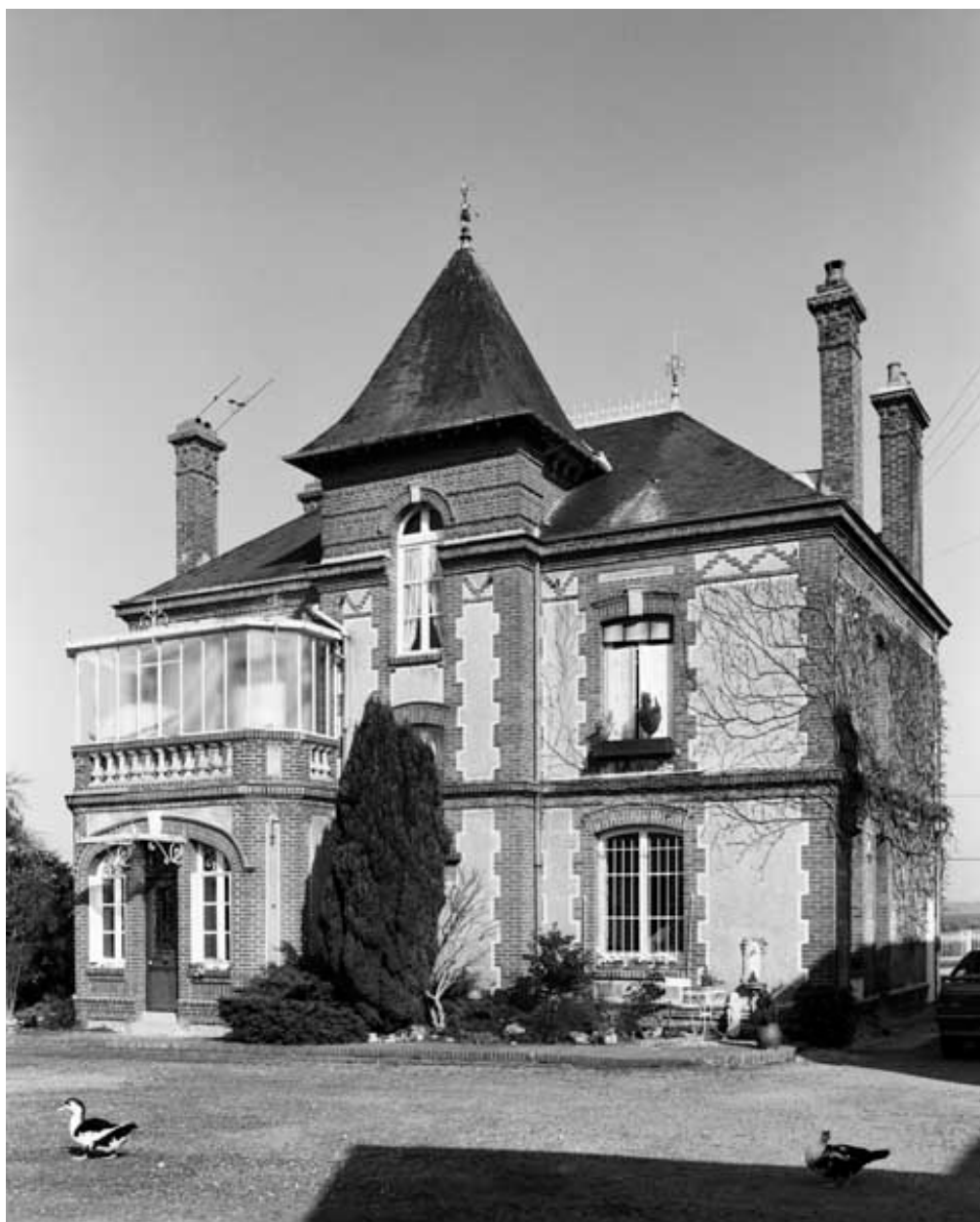
Logement patronal. Vue prise du sud.
