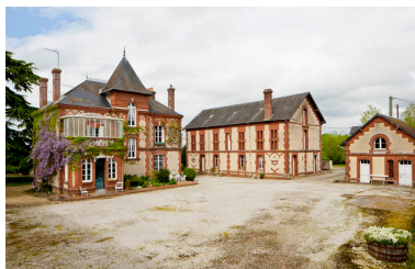
Vue d'ensemble du logement patronal et de la pièce d'affinage. Vue prise du sud-ouest. Phot. Manuel de Rugy IVR25_20121401076NUC2A
