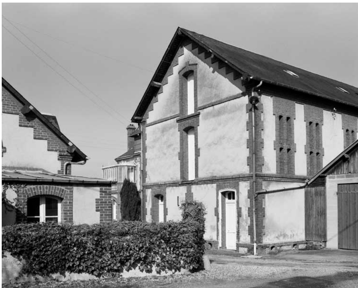
Pièce d'affinage. Vue prise du sud-est.
