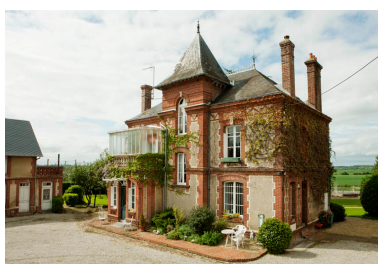
Logement patronal. Vue prise du sud-est. Phot. Manuel de Rugy IVR25_20121401078NUC2A
