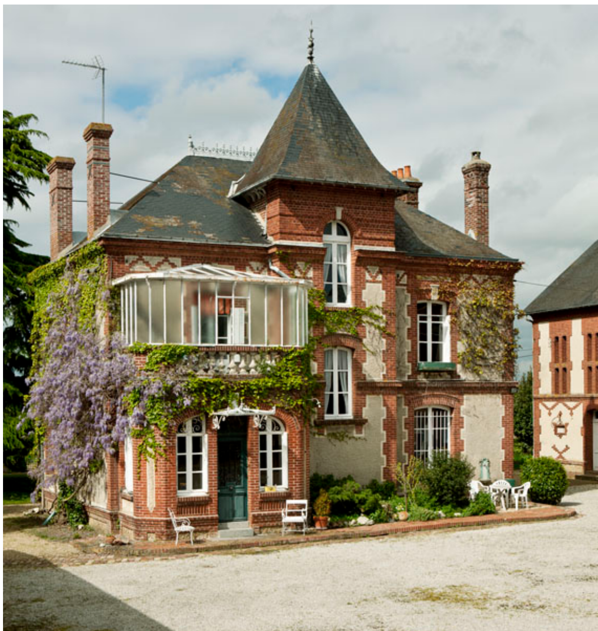
Logement patronal. Vue prise du sud-ouest.
