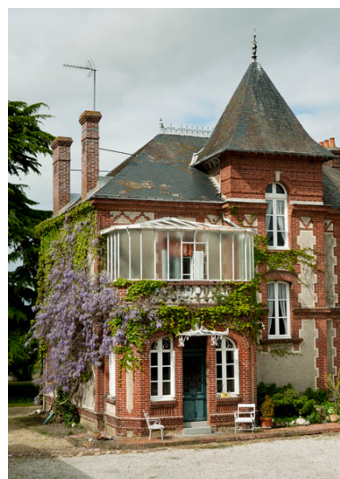
Logement patronal, détail de façade avec verrière. Vue prise du sud-ouest. Phot. Manuel de Rugy IVR25_20121401081NUC2A
