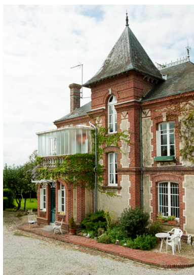
Logement patronal, détail de façade. Vue prise du sud-est. Phot. Manuel de Rugy IVR25_20121401079NUC2A
