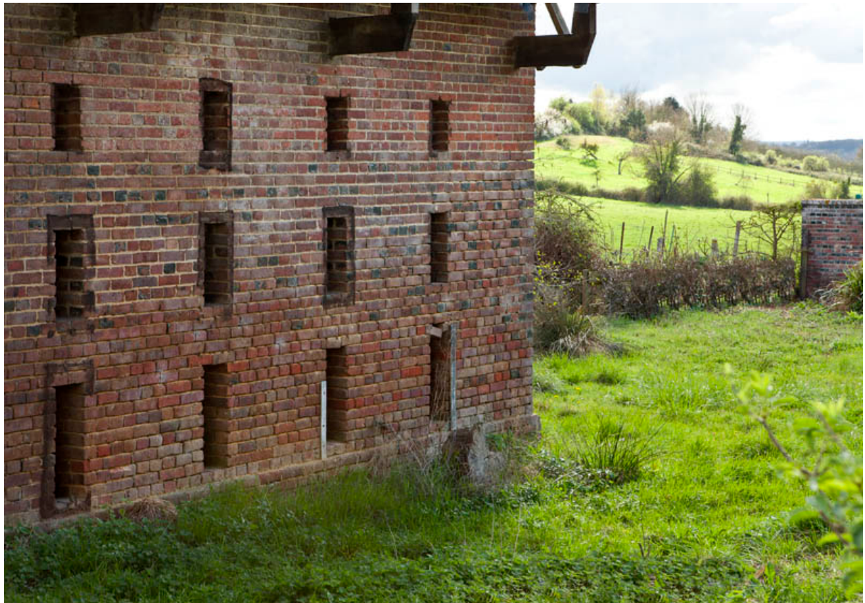
Pièce d'affinage, détail. Vue prise du nord-est.
