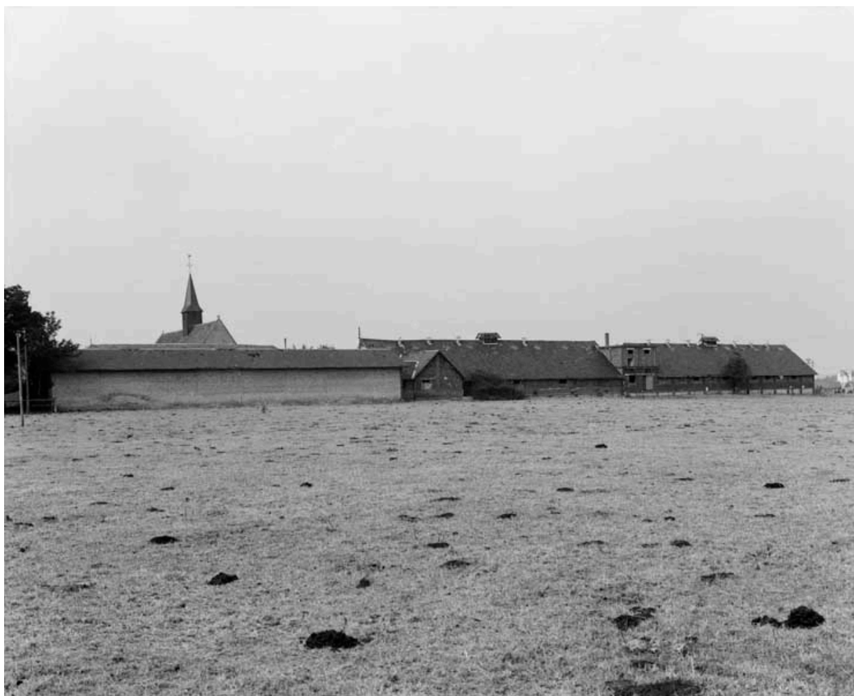
Vue d'ensemble des étables à vaches, prise de l'est.
