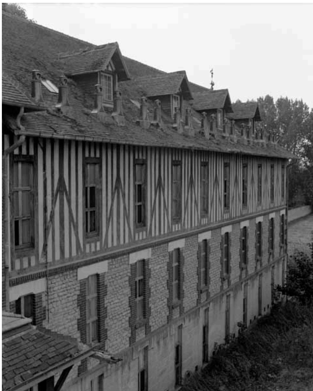
Pièce d'affinage (1). Elévation extérieure nord.
