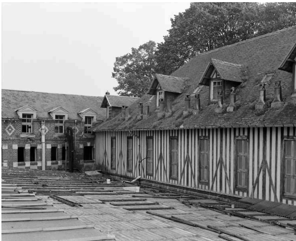
Pièce d'affinage (1). Elévation extérieure nord.
