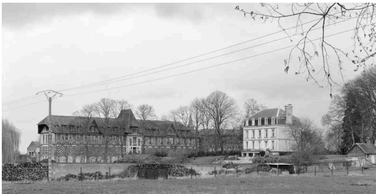
Pièce d'affinage (1) et logement patronal. Vue prise du sud-ouest.
