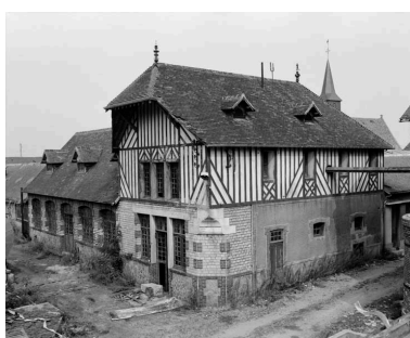
Logement. Vue prise du sud-ouest. Phot. Pascal Corbier IVR25_19891400624X
