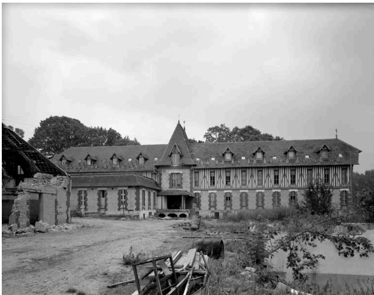
Pièce d'affinage (1). Vue prise du nord.
