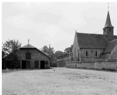
Etables à vaches (1). Vue prise du nord. Phot. Pascal Corbierre IVR25_19891400619X
