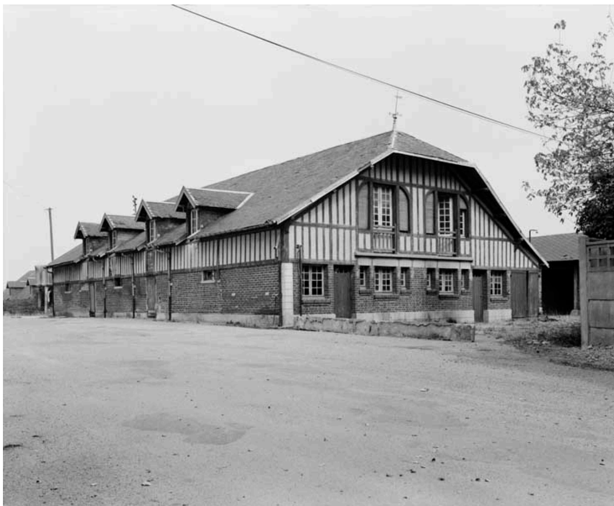
Etable à vaches (2). Vue prise du sud-ouest.
