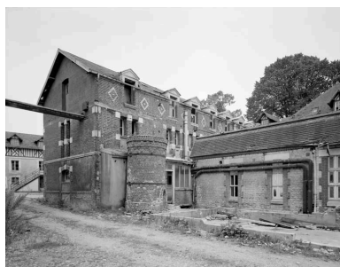
Pièce d'affinage (2) et base de la cheminée. Vue prise du nord-ouest. Phot. Pascal Corbier IVR25_19891400570V
