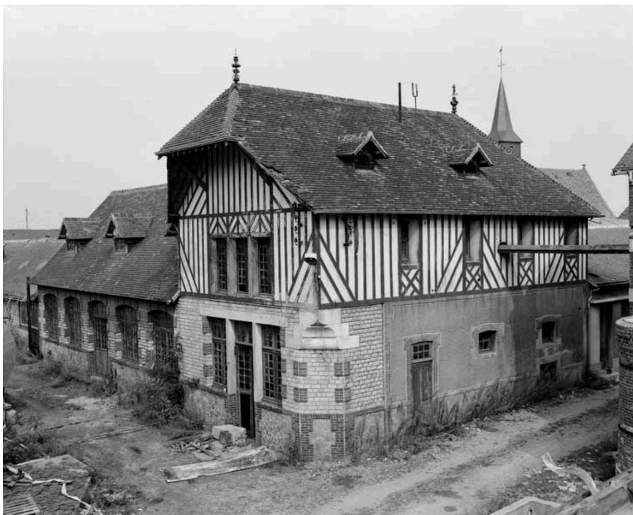
Logement. Vue prise du sud-ouest.
