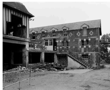
Pièce d'affinage (2). Vue prise de l'est. Phot. Pascal Corbier IVR25_19891400621X
