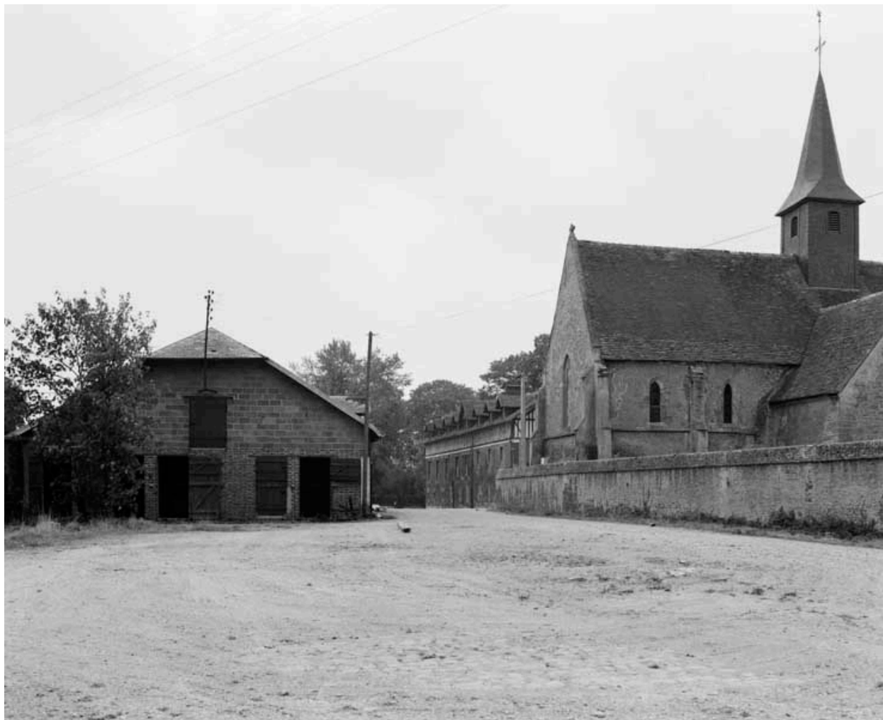
Etables à vaches (1). Vue prise du nord.
