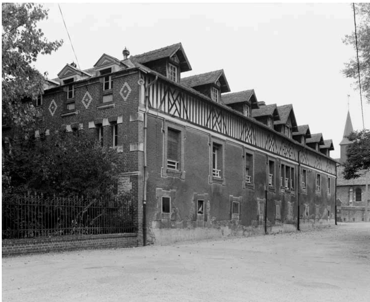
Atelier de fabrication. Vue prise du sud-est.
