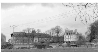
Pièce d'affinage (1) et logement patronal. Vue prise du sud-ouest. Phot. Pascal Corbierre IVR25_19951401289X
