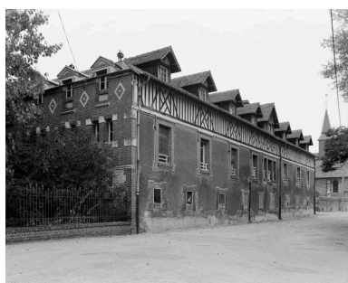
Atelier de fabrication. Vue prise du sud-est. Phot. Pascal Corbierre IVR25_19891400620X
