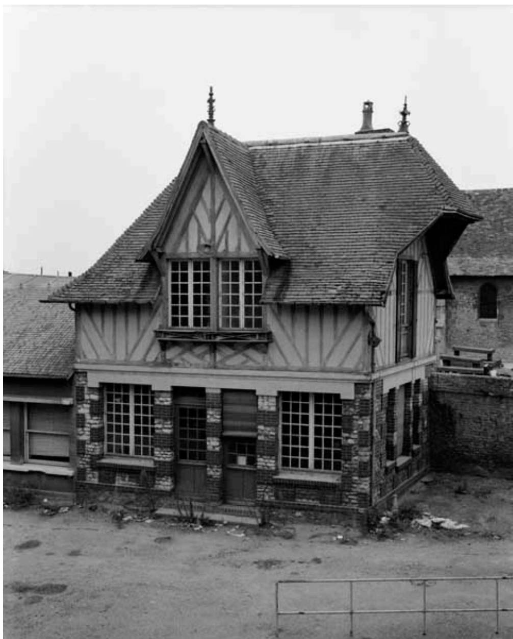
Bureau. Vue prise du sud-est.
