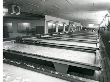
Cuves.- Photographie ancienne, vers 1970. (Collection particulière Jean Vallée). Phot. Manuel de Rugy IVR25_20141400262NUC2AB
