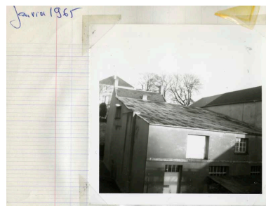
Photographie de chantier, janvier 1965, bâtiment des emballages vides.- Photographie ancienne, de l'architecte Contamin, janvier 1965. (Collection particulière Jean-Pierre Barette). Phot. Manuel de Ruy, Autr. Contamin (architecte) IVR25_20091400971NUC2AB
