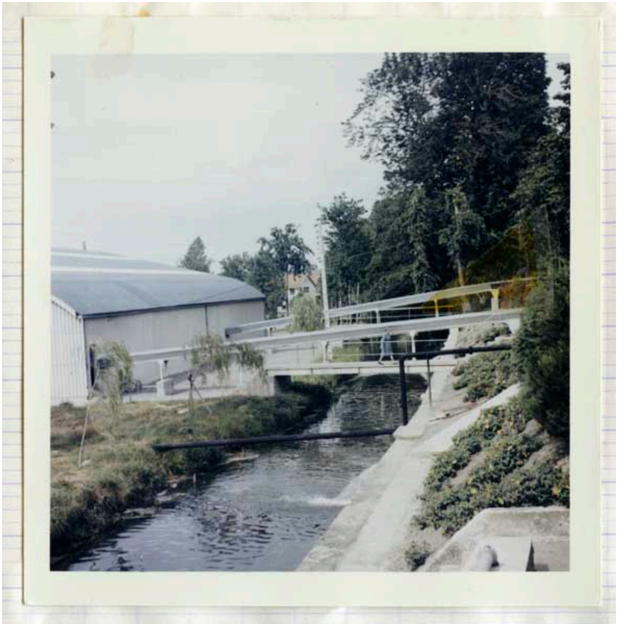
Photographie de chantier, 20 juillet 1965, bief de l'ancien moulin.- Photographie ancienne, de l'architecte Contamin, 20 juillet 1965. (Collection particulière Jean-Pierre Barette).
