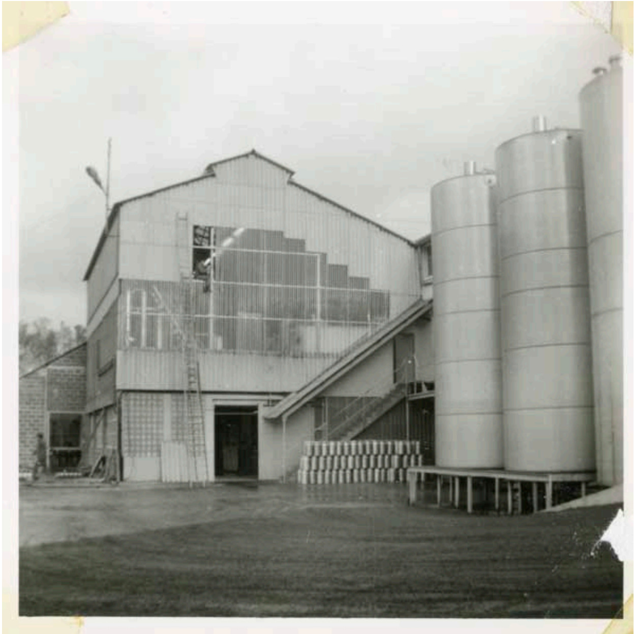
Photographie de chantier, janvier 1967, façade du bâtiment lait concentré.- Photographie ancienne, de l'architecte Contamin, janvier 1967. (Collection particulière Jean-Pierre Barette).
