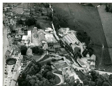
Vue aérienne de la laiterie industrielle Paillaud. Vue du nord-ouest.- Photographie ancienne, de R.J. Paté, s.d., milieu 20e siècle. (Collection particulière Jean-Pierre Barette). Phot. Manuel de Rugy, Autr. R.J. (photographe) Paté IVR25_20091400968NUC2AB
