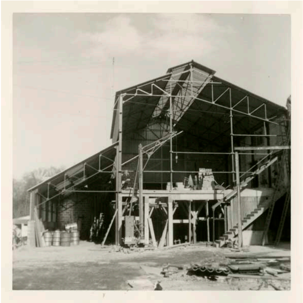
Photographie de chantier, 7 mars 1963, construction du bâtiment pour la fabrication du lait concentré.- Photographie ancienne, de l'architecte Contamin, 7 mars 1963. (Collection particulière Jean-Pierre Barette).
