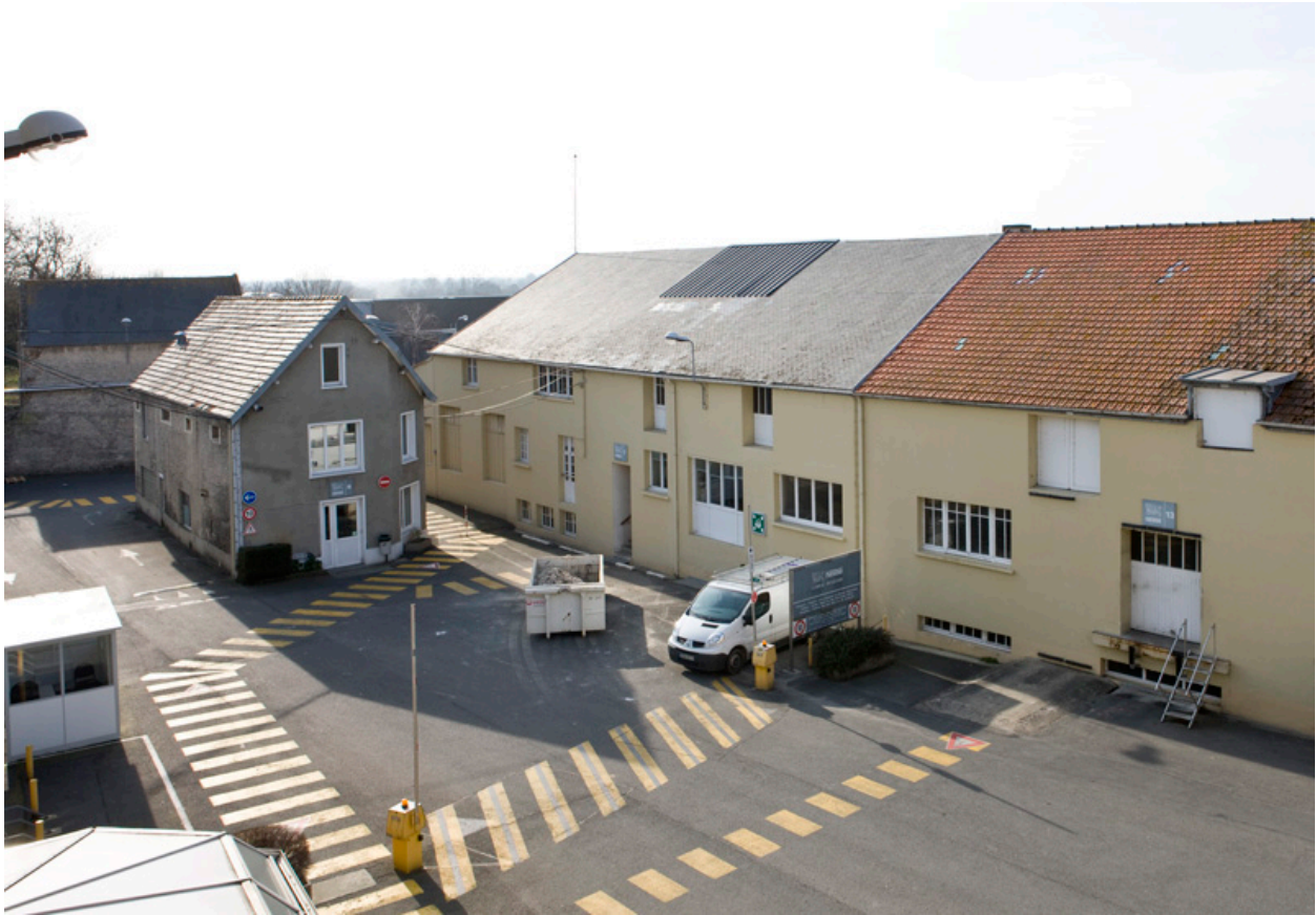
Atelier de fabrication, vue prise du sud-est.
