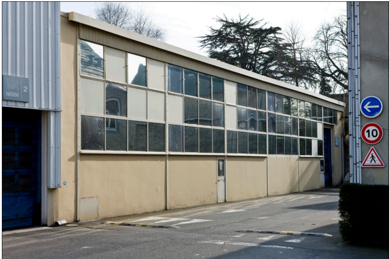
Atelier de fabrication, ancienne ferblanterie, vue prise du nord-est.
