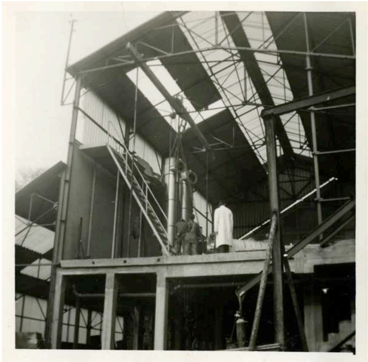
Photographie de chantier, mars 1963, construction du bâtiment pour la fabrication du lait concentré, ossature et charpente métallique.- Photographie ancienne, de l'architecte Contamin, mars 1963. (Collection particulière Jean-Pierre Barette).
