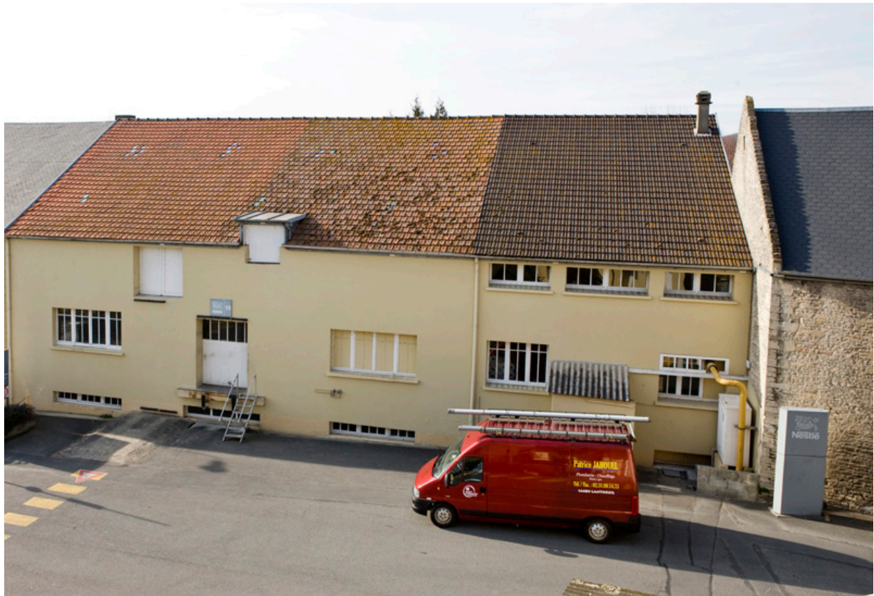
Atelier de fabrication, vue prise du sud-est.
