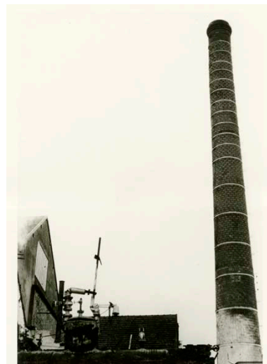
Photographie de chantier, explosion de la chaudière, novembre 1962, cheminée à vapeur.- Photographie ancienne, de l'architecte Contamin, novembre 1962. (Collection particulière Jean-Pierre Barette). Phot. Manuel de Ruy, Autr. Contamin (architecte) IVR25_20091400981NUC2AB
