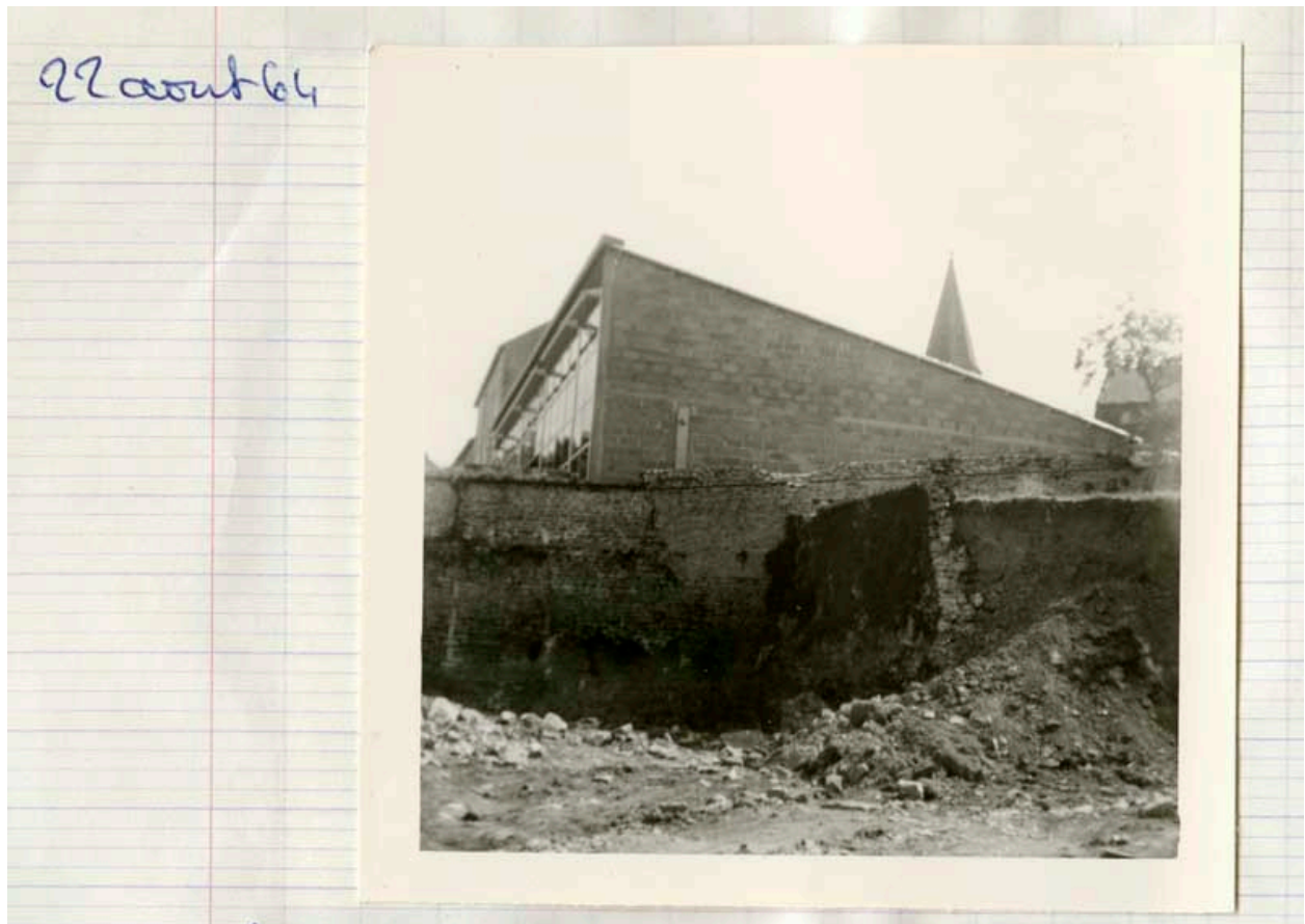
Photographie de chantier, 22 août 1964, vue sur l'atelier de ferblanterie.- Photographie ancienne, de l'architecte Contamin, 22 août 1964. (Collection particulière Jean-Pierre Barette).
