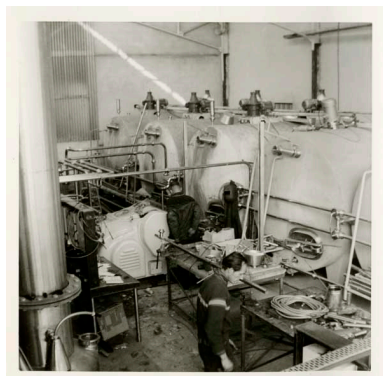
Photographie de chantier, mai 1963, construction du bâtiment pour la fabrication du lait concentré, installation des cuves pour le lait.- Photographie ancienne, de l'architecte Contamin, mai 1963. (Collection particulière Jean-Pierre Barette). Phot. Manuel de Ruy, Autr. Contamin (architecte) IVR25_20091400986NUC2AB
