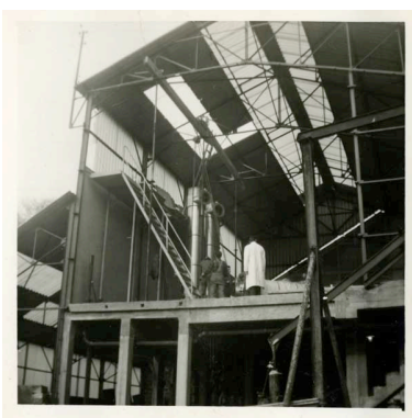
Photographie de chantier, mars 1963, construction du bâtiment pour la fabrication du lait concentré, ossature et charpente métallique.- Photographie ancienne, de l'architecte Contamin, mars 1963. (Collection particulière Jean-Pierre Barette). Phot. Manuel de Ruy, Autr. Contamin (architecte) IVR25_20091400984NUC2AB
