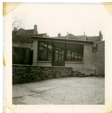
Photographie de chantier, 12 février 1966, cantine.- Photographie ancienne, de l'architecte Contamin, 12 février 1966. (Collection particulière Jean-Pierre Barette). Phot. Manuel de Ruy, Autr. Contamin (architecte)
