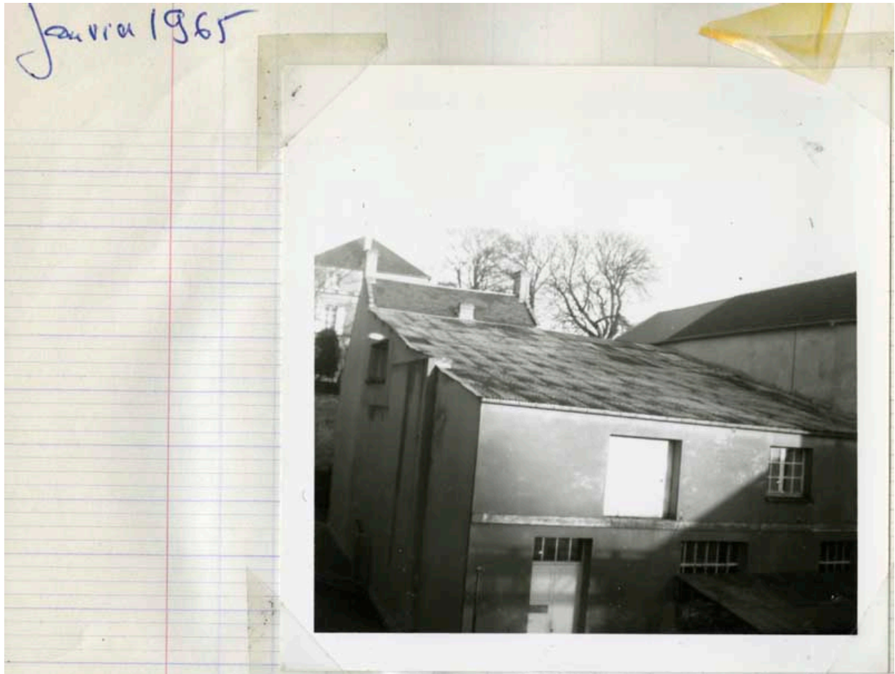
Photographie de chantier, janvier 1965, bâtiment des emballages vides.- Photographie ancienne, de l'architecte Contamin, janvier 1965. (Collection particulière Jean-Pierre Barette).
