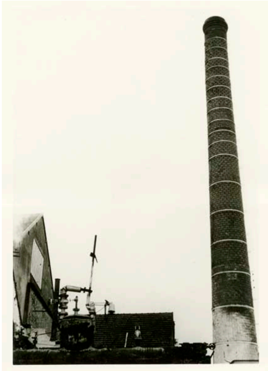
Photographie de chantier, explosion de la chaudière, novembre 1962, cheminée à vapeur.- Photographie ancienne, de l'architecte Contamin, novembre 1962. (Collection particulière Jean-Pierre Barette).
