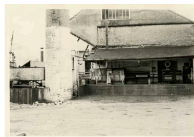
Photographie de chantier, explosion de la chaudière, novembre 1962, quai de déchargement du lait avec pied de la cheminée à vapeur.- Photographie ancienne, de l'architecte Contamin, novembre 1962. (Collection particulière Jean-Pierre Barette). Phot. Manuel de Ruy, Autr. Contamin (architecte) IVR25_20091400978NUC2AB
