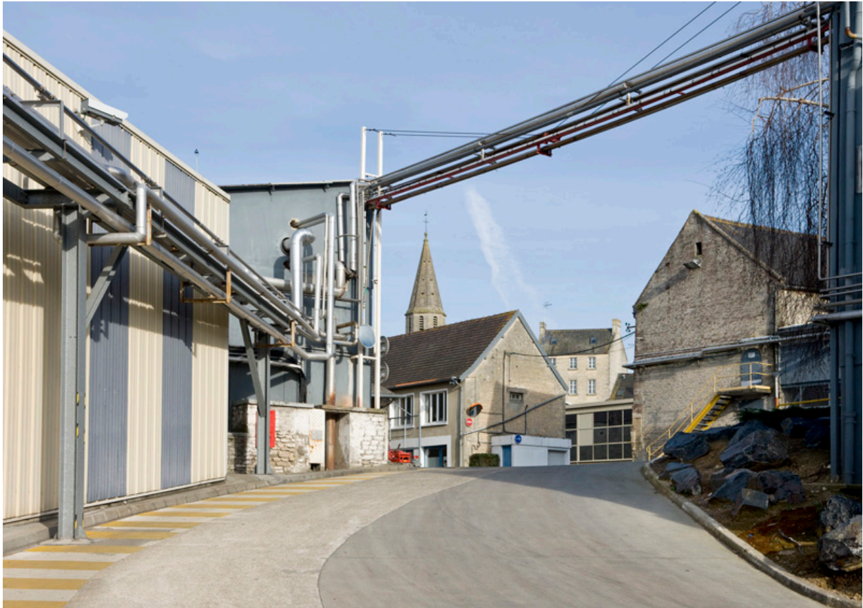
Vue d'ensemble des bâtiments et voie de circulation, vue de l'ouest.
