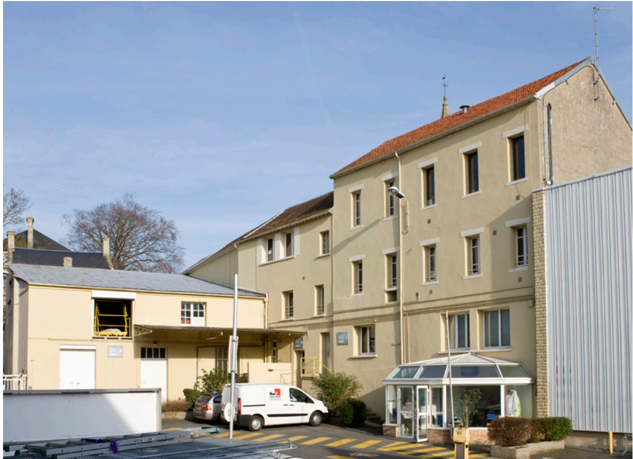
Bureaux, vue du nord-ouest.
