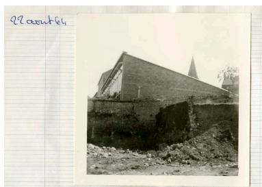
Photographie de chantier, 22 août 1964, vue sur l'atelier de ferblanterie.- Photographie ancienne, de l'architecte Contamin, 22 août 1964. (Collection particulière Jean-Pierre Barette). Phot. Manuel de Ruy, Autr. Contamin (architecte) IVR25_20091400969NUC2AB
