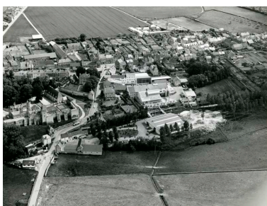
Vue aérienne de la laiterie industrielle Paillaud. Vue du nord-est.- Photographie ancienne, s.d., milieu 20e siècle. (Collection particulière Jean-Pierre Barette). Phot. Manuel de Rugy, Autr. R.J. (photographe) Paté IVR25_20091400967NUC2AB
