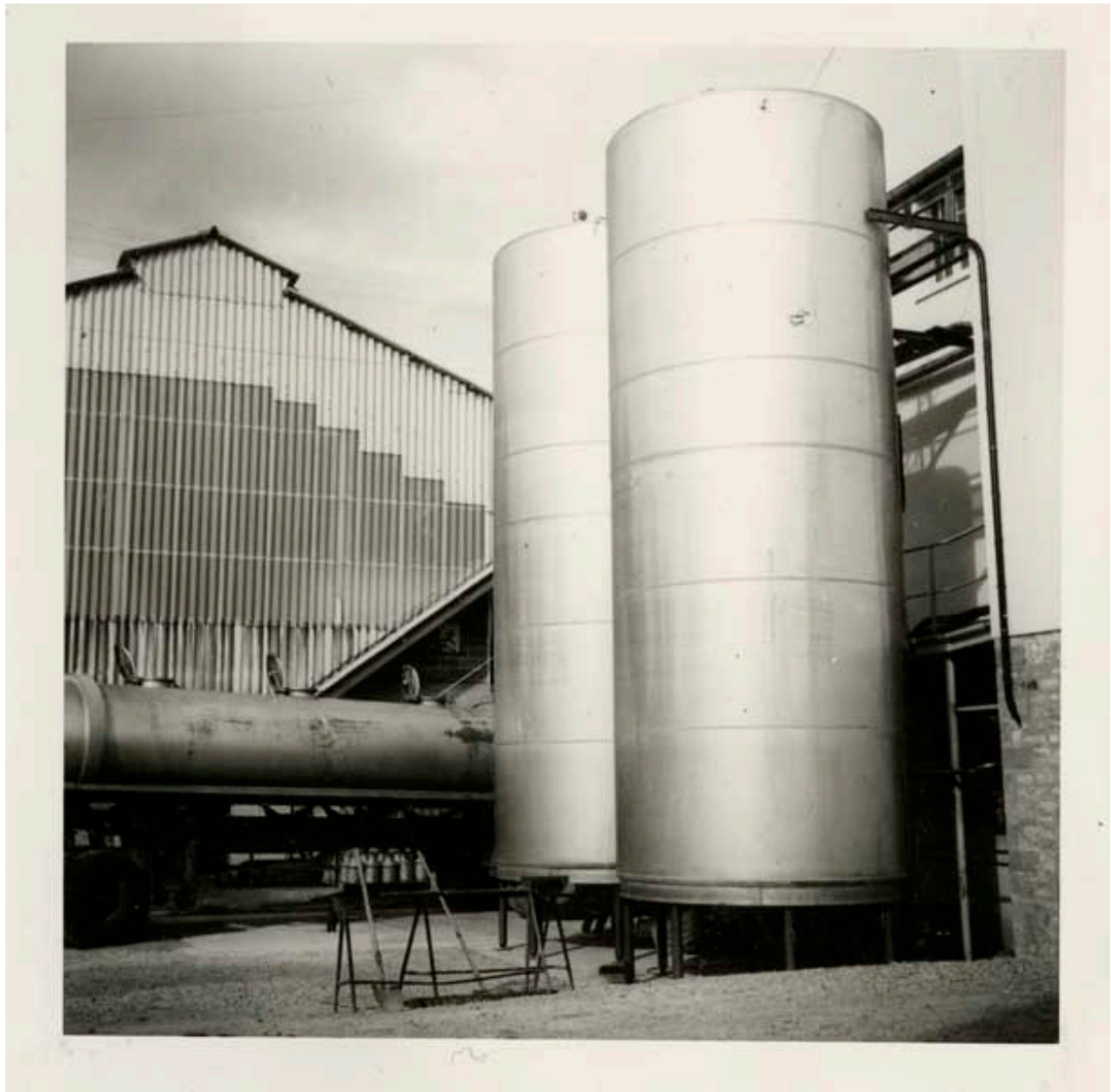
Photographie de chantier, juin 1964, façade du bâtiment pour la fabrication du lait concentré et cuves extérieures.- Photographie ancienne, de l'architecte Contamin, juin 1964. (Collection particulière Jean-Pierre Barette).
