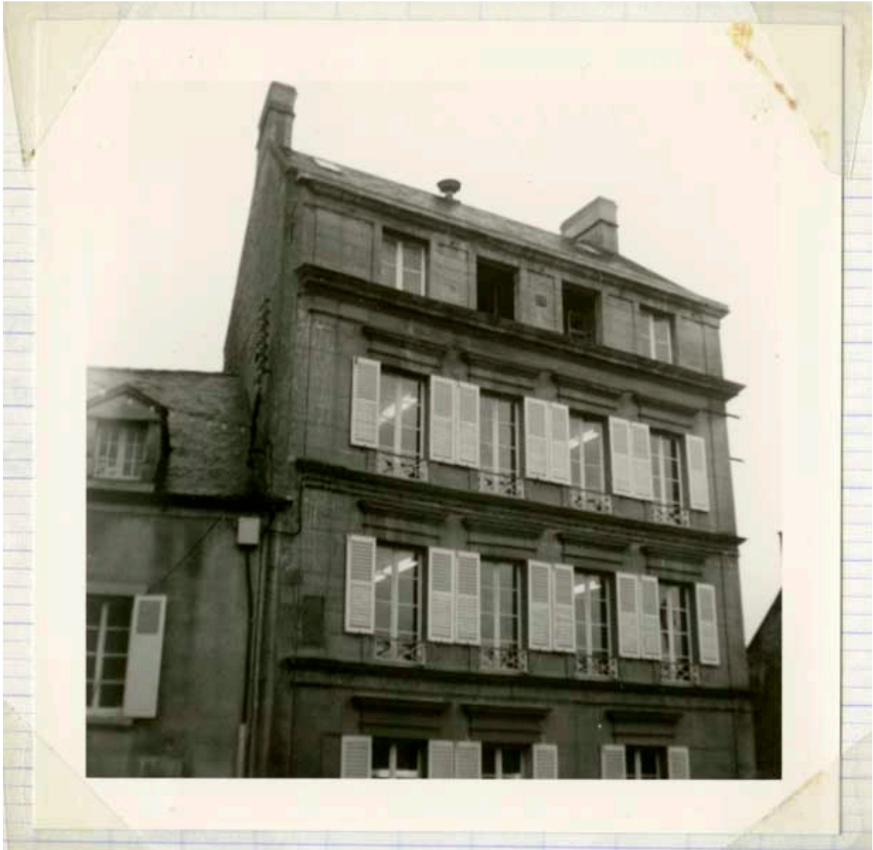
Photographie de chantier, 1966, façade des bureaux du siège.- Photographie ancienne, de l'architecte Contamin, 1966. (Collection particulière Jean-Pierre Barette).
