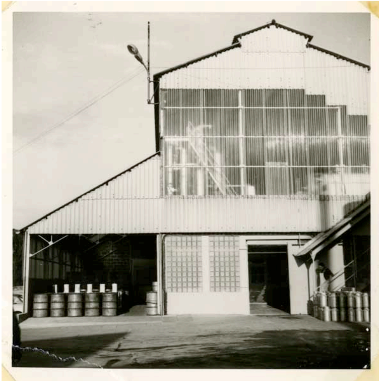
Photographie de chantier, janvier 1967, local sucre en vrac.- Photographie ancienne, de l'architecte Contamin, janvier 1967. (Collection particulière Jean-Pierre Barette).
