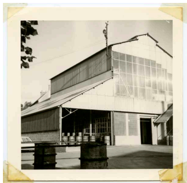
Photographie de chantier, octobre 1966, local sucre en vrac.- Photographie ancienne, de l'architecte Contamin, octobre 1966. (Collection particulière Jean-Pierre Barette). Phot. Manuel de Rugy, Autr. Contamin (architecte) IVR25_20091400975NUC2AB
