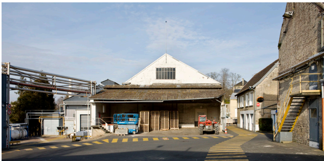
Atelier de fabrication, vue du sud-ouest.
