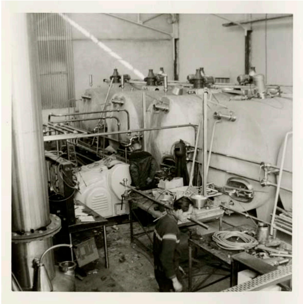
Photographie de chantier, mai 1963, construction du bâtiment pour la fabrication du lait concentré, installation des cuves pour le lait.- Photographie ancienne, de l'architecte Contamin, mai 1963. (Collection particulière Jean-Pierre Barette).
