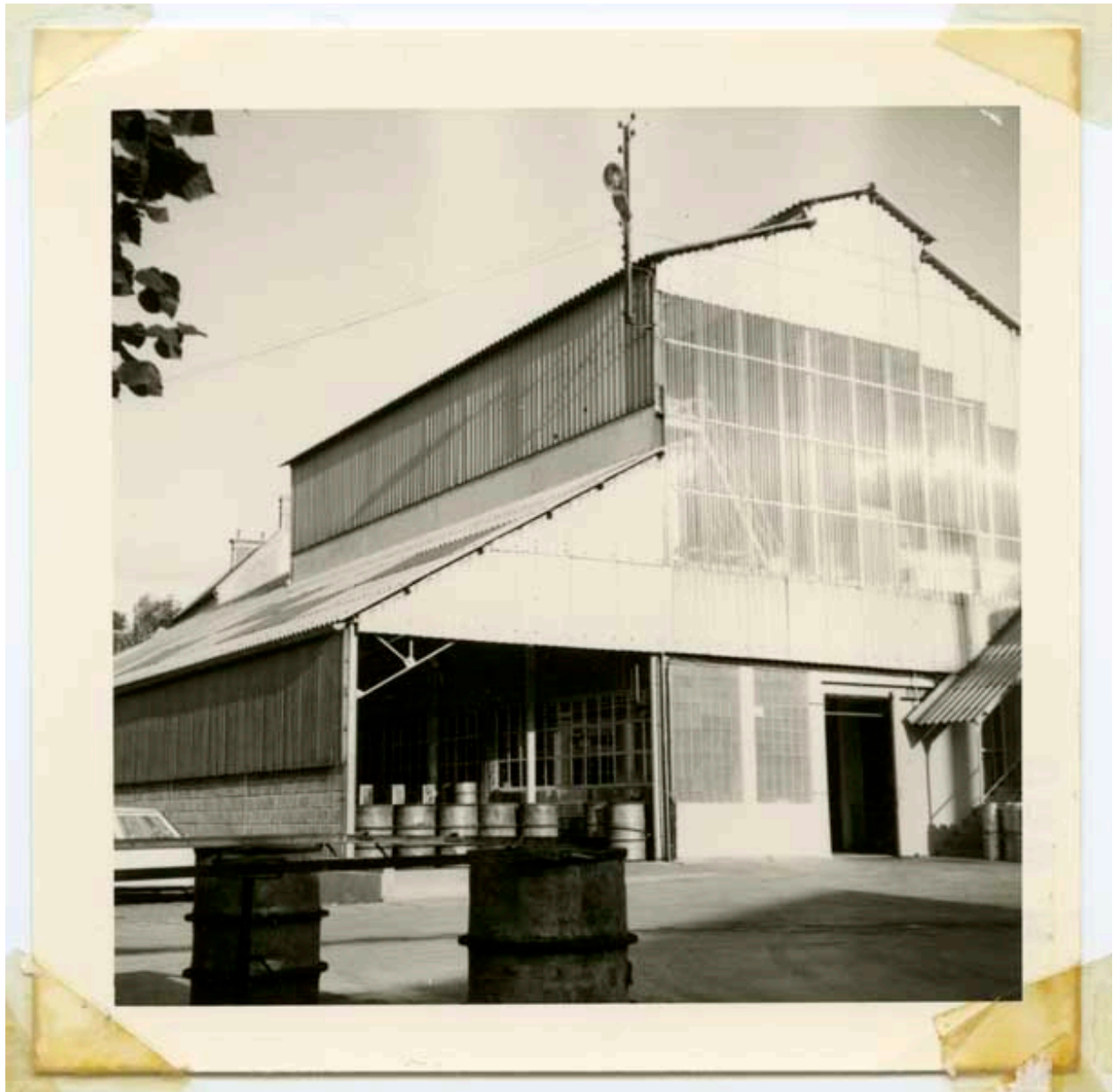
Photographie de chantier, octobre 1966, local sucre en vrac.- Photographie ancienne, de l'architecte Contamin, octobre 1966. (Collection particulière Jean-Pierre Barette).
