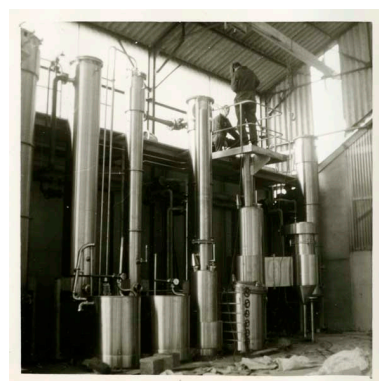
Photographie de chantier, mars 1963, construction du bâtiment pour la fabrication du lait concentré, installation des machines.- Photographie ancienne, de l'architecte Contamin, mars 1963. (Collection particulière Jean-Pierre Barette). Phot. Manuel de Ruy, Autr. Contamin (architecte) IVR25_20091400985NUC2AB
