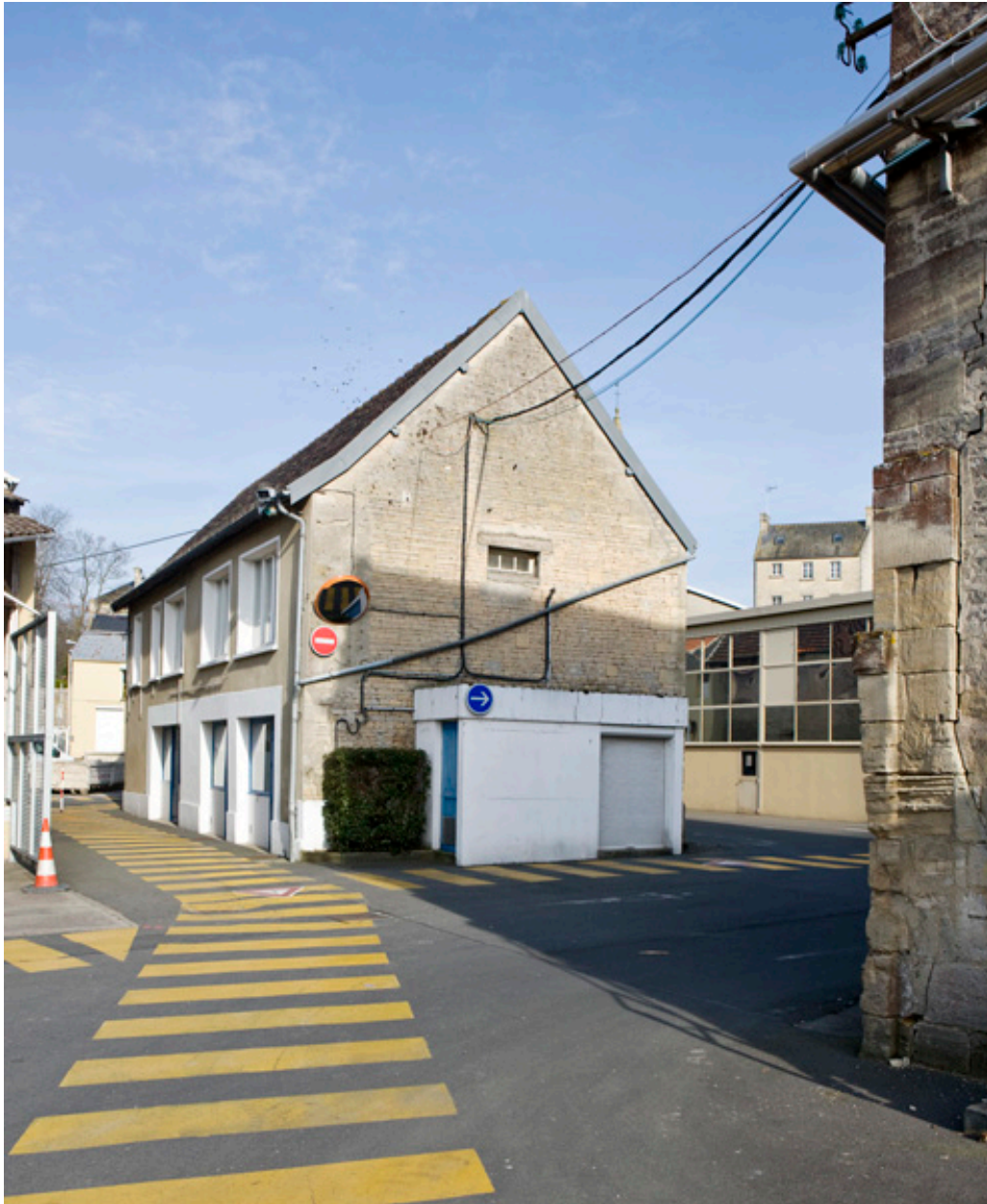
Laboratoire et bureaux, vue de l'ouest.
