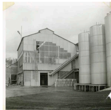
Photographie de chantier, janvier 1967, façade du bâtiment lait concentré.- Photographie ancienne, de l'architecte Contamin, janvier 1967. (Collection particulière Jean-Pierre Barette). Phot. Manuel de Rugy, Autr. Contamin (architecte) IVR25_20091400977NUC2AB
