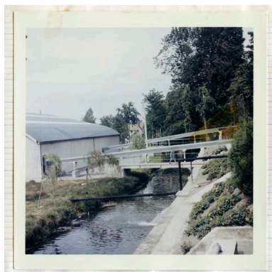
Photographie de chantier, 20 juillet 1965, bief de l'ancien moulin.- Photographie ancienne, de l'architecte Contamin, 20 juillet 1965. (Collection particulière Jean-Pierre Barette). Phot. Manuel de Ruy, Autr. Contamin (architecte)
