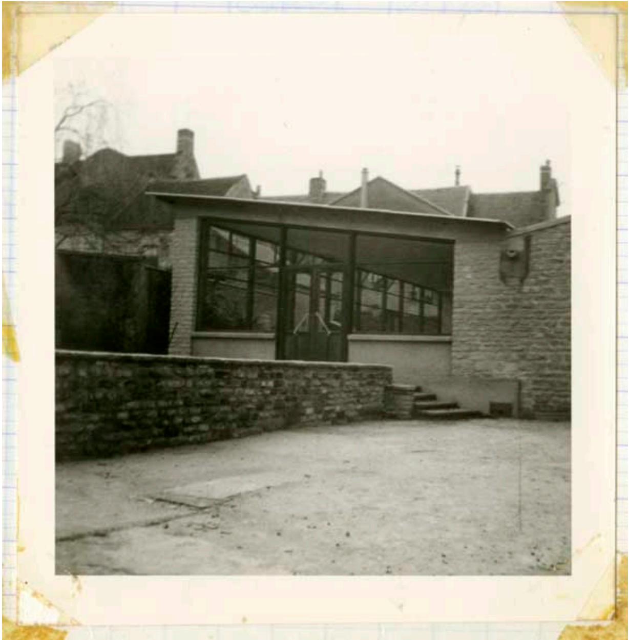
Photographie de chantier, 12 février 1966, cantine.- Photographie ancienne, de l'architecte Contamin, 12 février 1966. (Collection particulière Jean-Pierre Barette).
