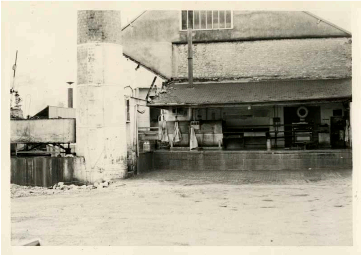
Photographie de chantier, explosion de la chaudière, novembre 1962, quai de déchargement du lait avec pied de la cheminée à vapeur.- Photographie ancienne, de l'architecte Contamin, novembre 1962. (Collection particulière Jean-Pierre Barette).
