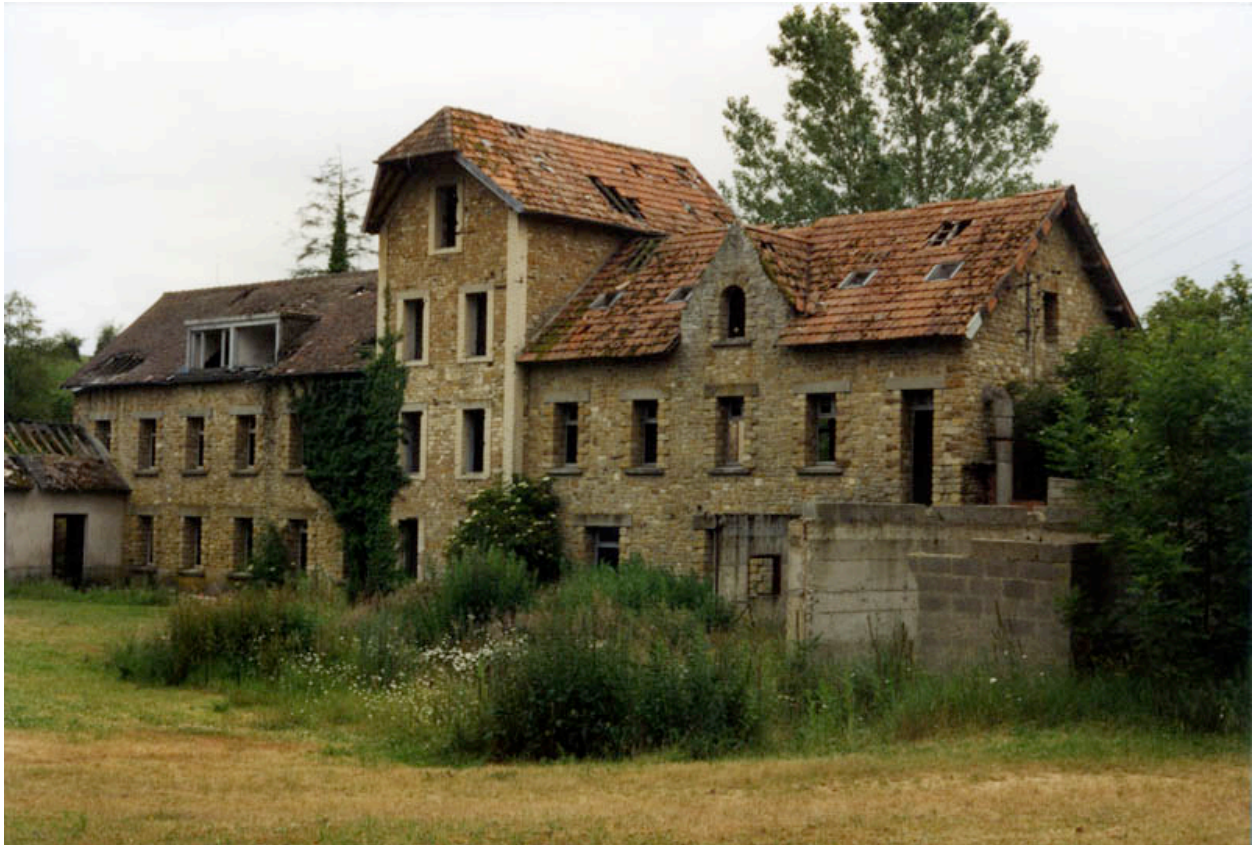
Etat de la fromagerie avant travaux.- Photographie ancienne. (Collection particulière P. Coftier).
