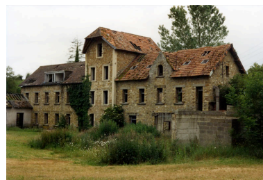
Etat de la fromagerie avant travaux.- Photographie ancienne. (Collection particulière P. Coftier). Phot. Manuel de Ruyg, Autr. inconnu auteur IVR25_20111401658NUC2AB
