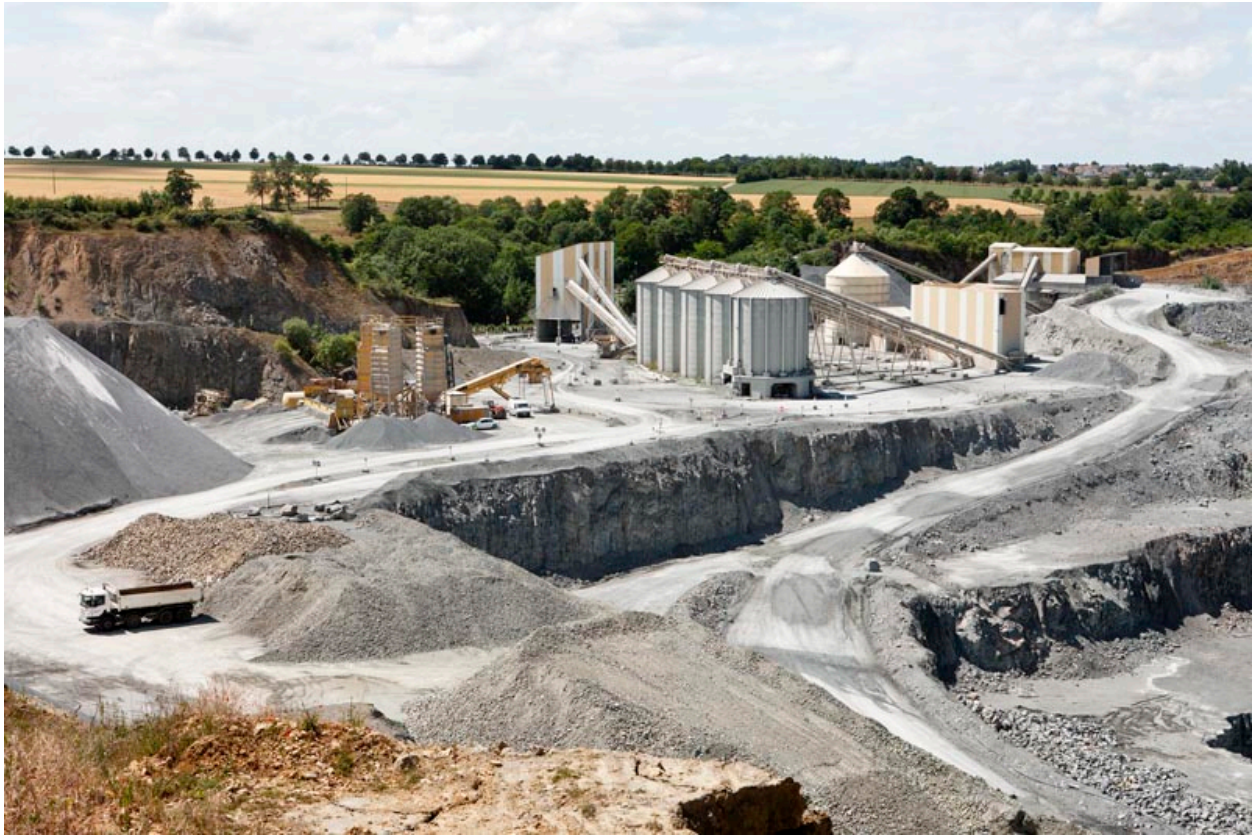
Vue d'ensemble des installations de concassage, prise du sud-est.
