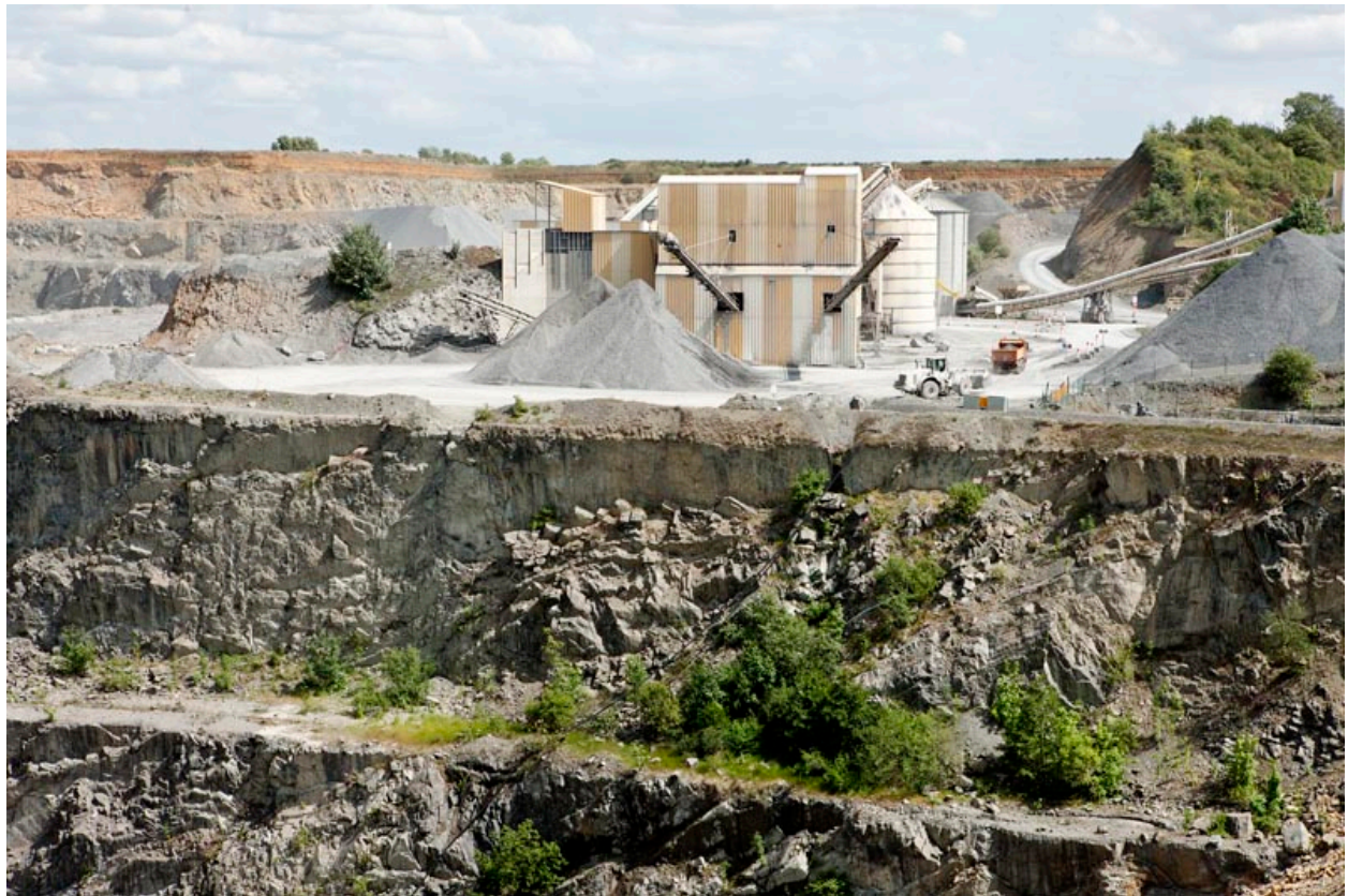
Poste de concassage primaire, vue du nord-ouest.
