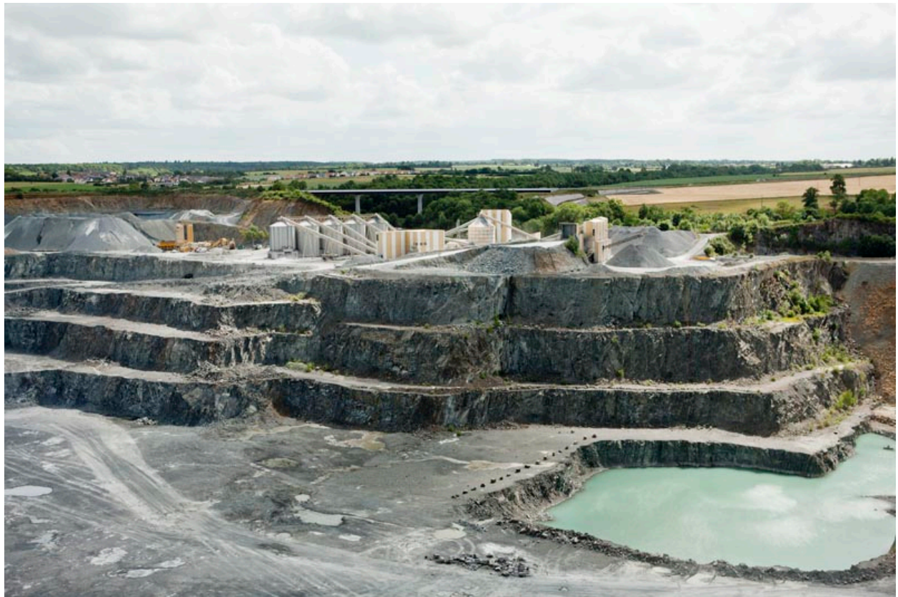
Installations de concassage et de broyage au sommet des paliers d'exploitation et bassin, vue du l'est.
