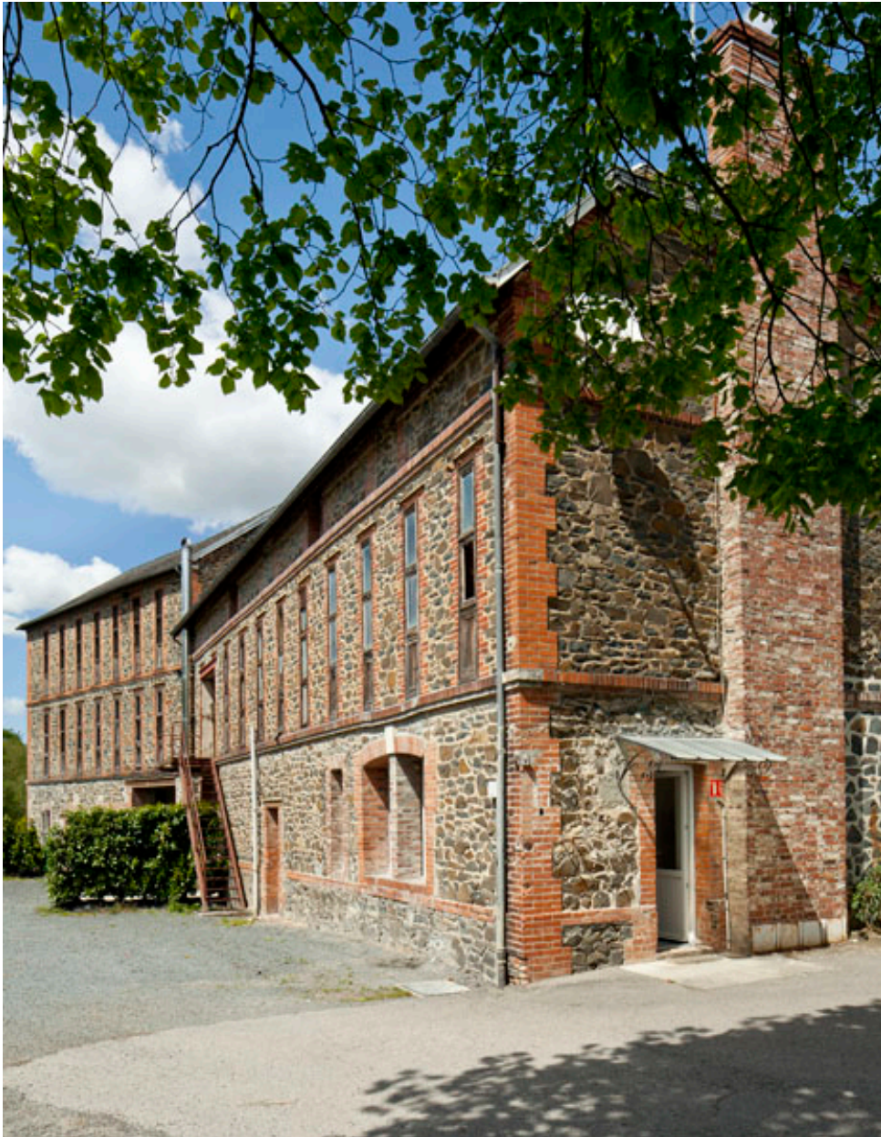
Bâtiment des hâloirs de l'ancienne fromagerie, vue du sud.
