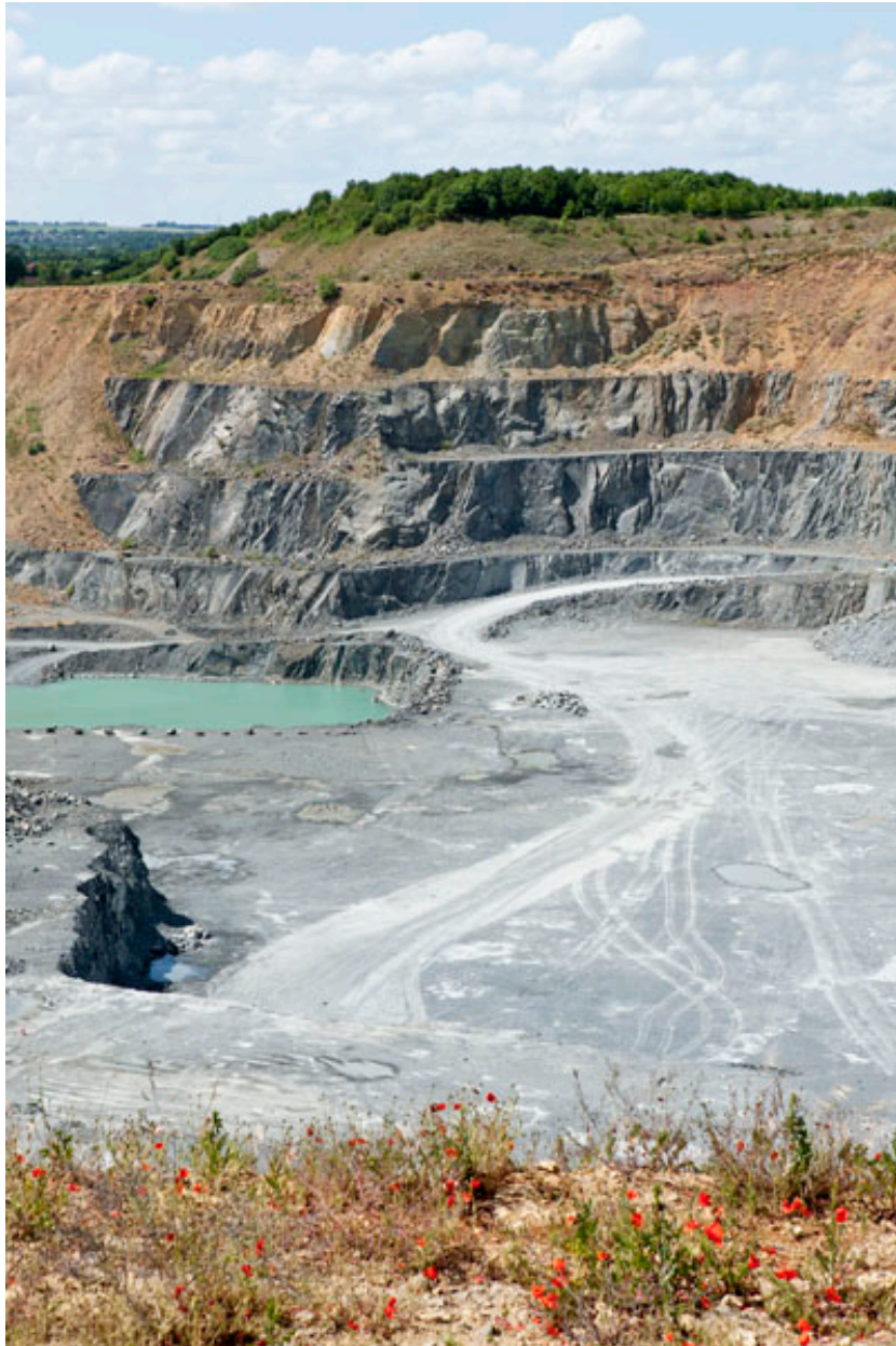
Vue d'ensemble de parties revégétalisées, de paliers d'exploitation et du bassin, prise du sud-est.
