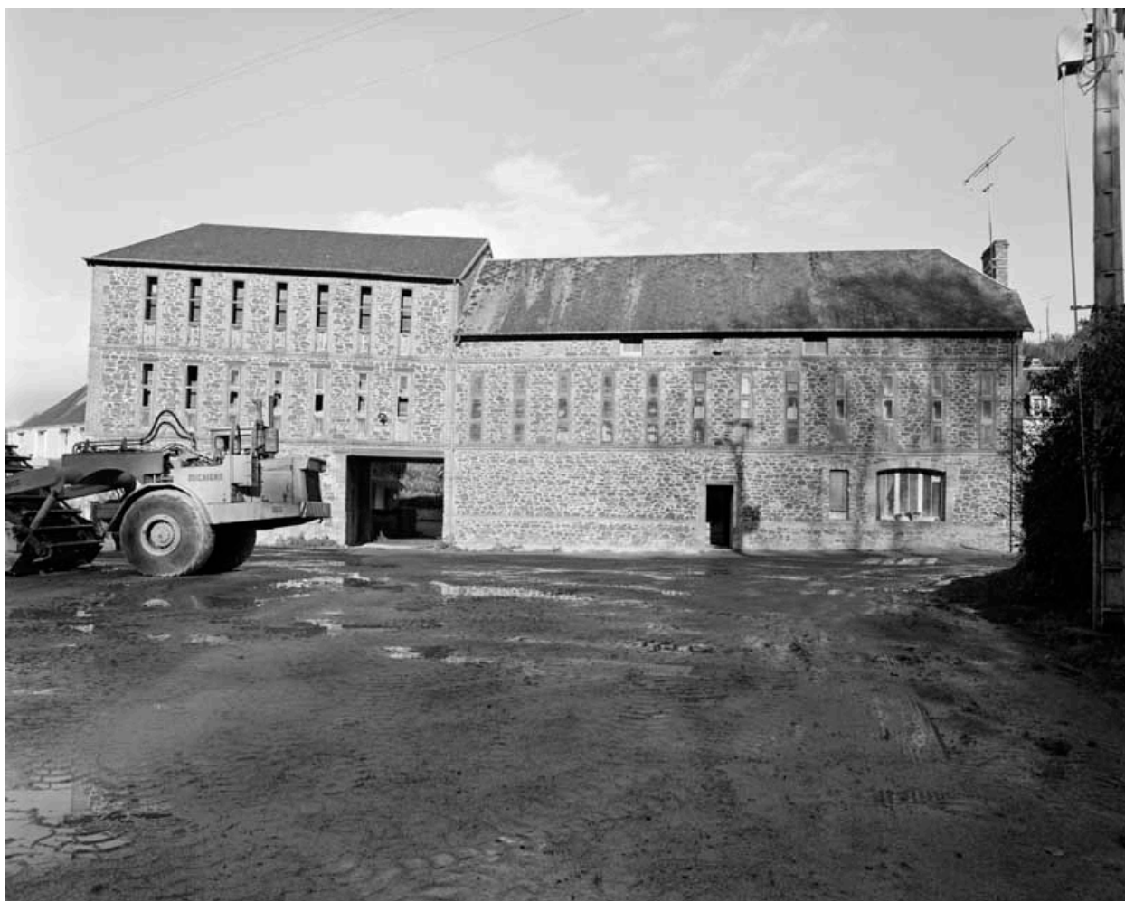
Usine, élévation extérieure sud.- Photographie ancienne, 1981.
