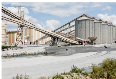
Postes secondaires et tertiaires reliés aux silos, vue du sud-ouest. Phot. Manuel de Ruggy IVR25_20111401034NUC2A
