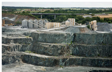
Installations de concassage et de broyage au sommet des paliers d'exploitation, vue du est. Phot. Manuel de Ruggy
