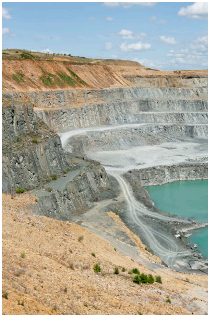
Vue d'ensemble des paliers d'exploitation et du bassin, prise du nord-ouest.
