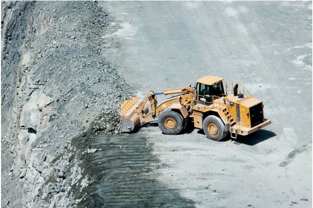
Pelle dégageant le flanc ayant été travaillé au tir de mine.
