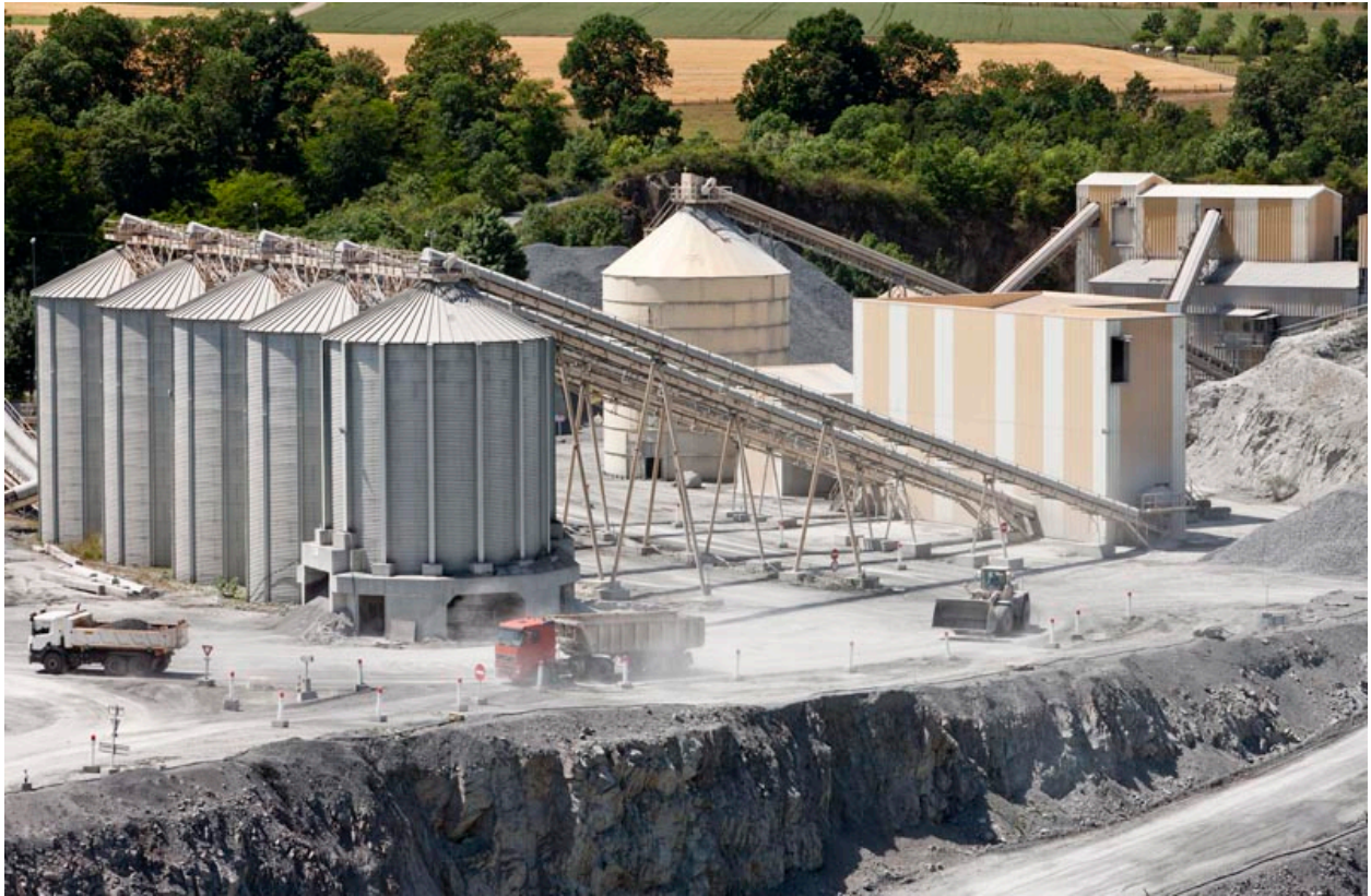
Postes de concassages (de droite à gauche) primaire, secondaire et tertiaire et silos, vue du sud-est.
