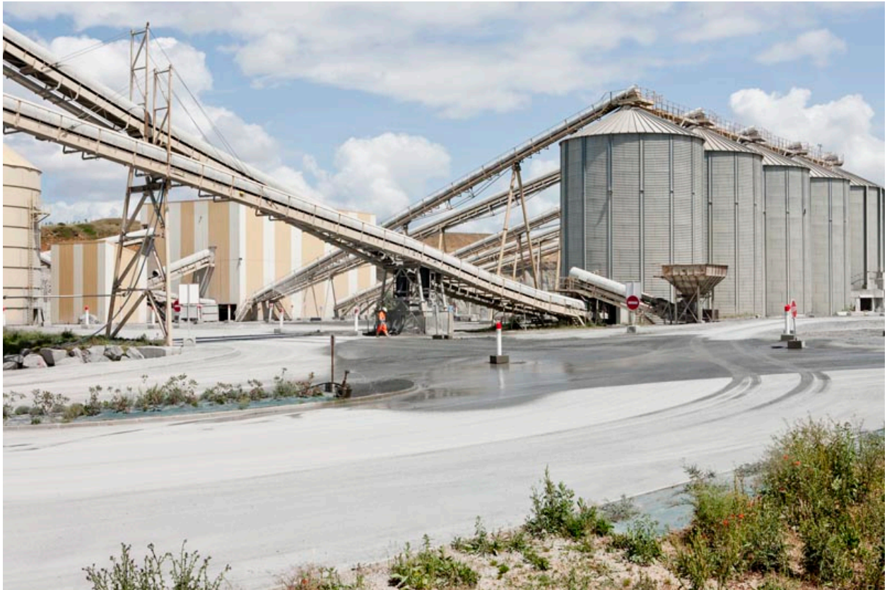
Postes secondaires et tertiaires reliés aux silos, vue du sud-ouest.
