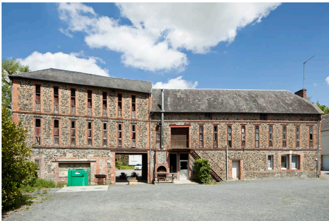
Vue d'ensemble du bâtiment des hâloirs de l'ancienne fromagerie, vue du sud-ouest.
