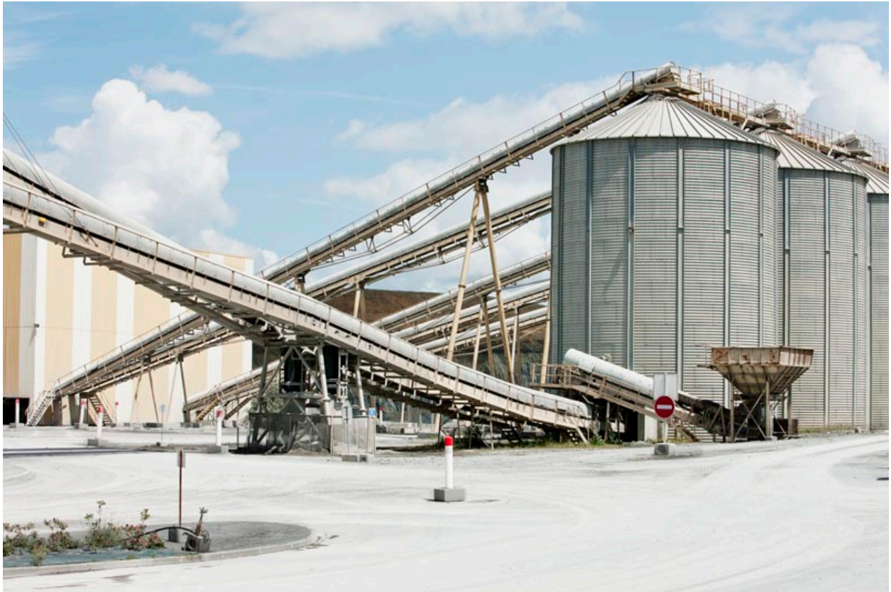
Silos et système de convoyage, vue du sud-ouest.
