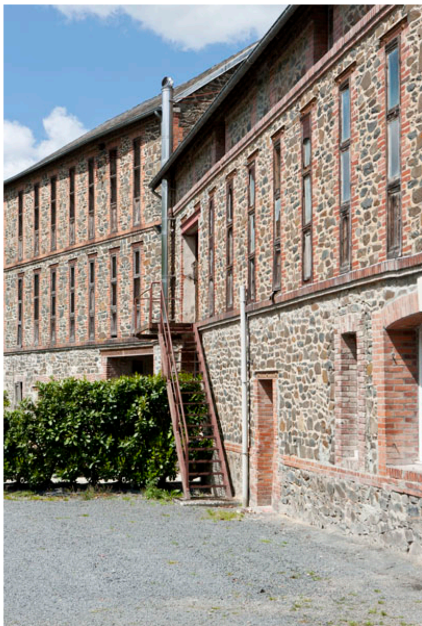
Bâtiment des hâloirs de l'ancienne fromagerie, partie centrale, vue du sud.
