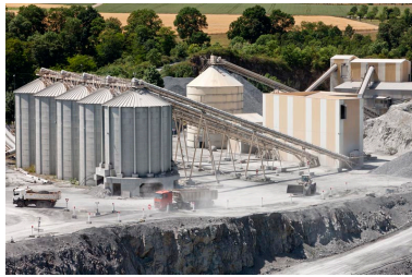
Postes de concassages (de droite à gauche) primaire, secondaire et tertiaire et silos, vue du sud-est. Phot. Manuel de Ruggy, Phot. Inventaire IVR25_20111401040NUC2A
